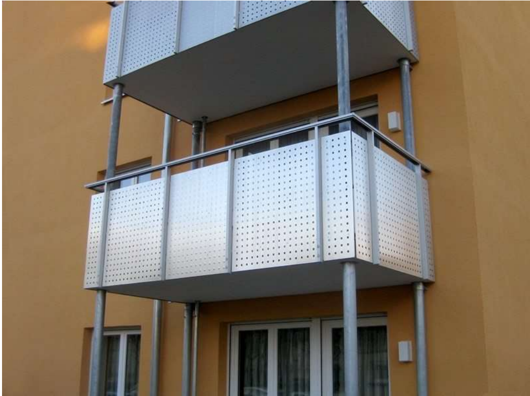
Obrázek 6 - Ocelový samonosný balkon (PEKSTRA s.r.o., nedatováno)
