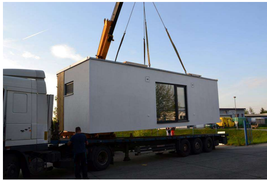
Obrázek 6 - Doprava a usazení modulového domu [13]
