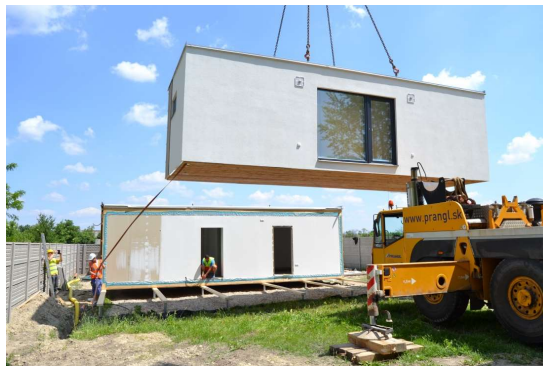
Obrázek 7 - Usazení modulového domu na připravený základový rošt [13]
