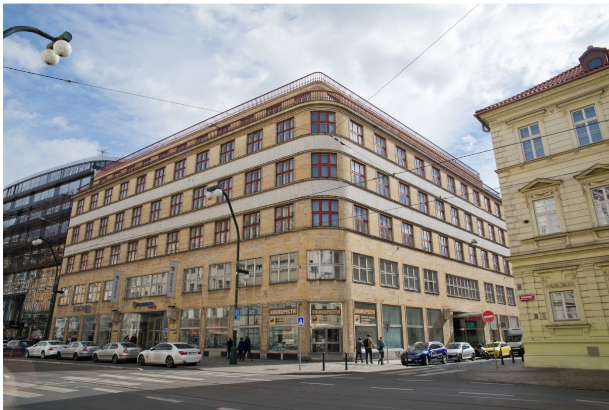
Obrázek č. 6: Budova SPS
