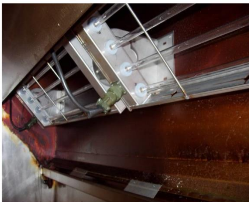
Obrázok 9 : Príklad dodatočnej inštalácie UV-C filtrácie pred a po uvedením do prevádzky [10]
