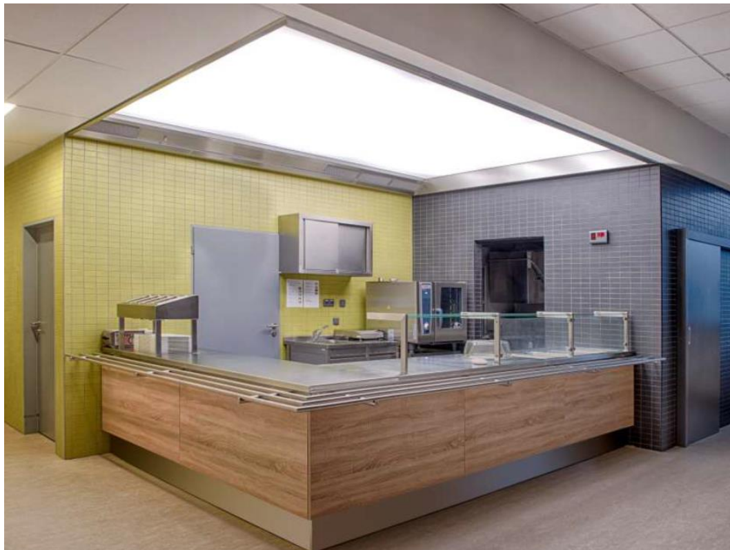
Obrázok 8 : Príklad veľkoplášneho odvetrávacieho stropu v otvorenom výdaji [8]
