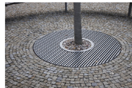
MŘÍŽ KE STROMŮM (M4)
