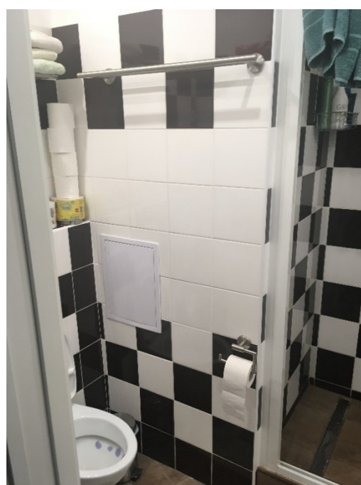
Obr. 16 Stěna, kterou budeme posuzovat vedle WC
