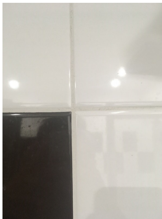
Obr. 25 Detail šířky a stejnoměrnosti spáry
