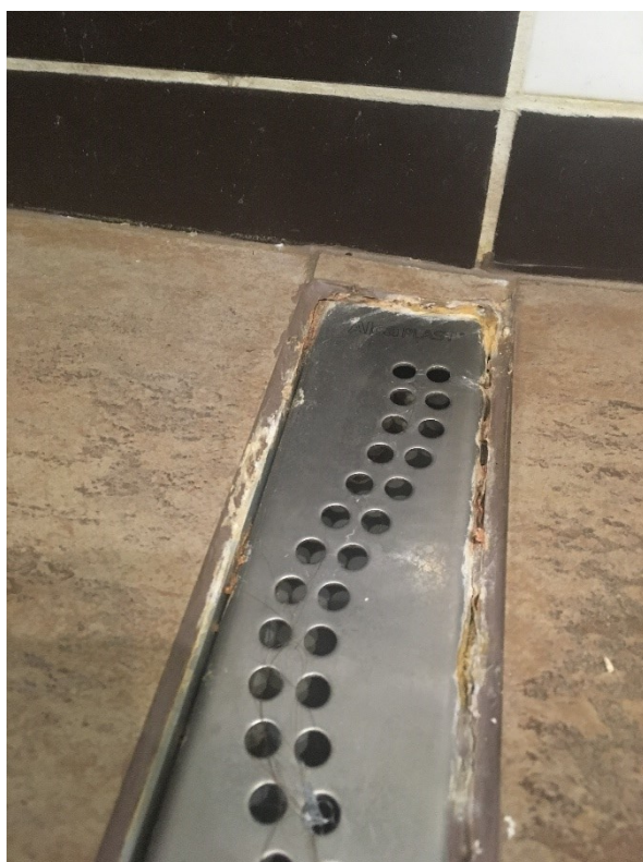
Obr. 20 Napojení dlažby na odtokový žlab ve sprše
