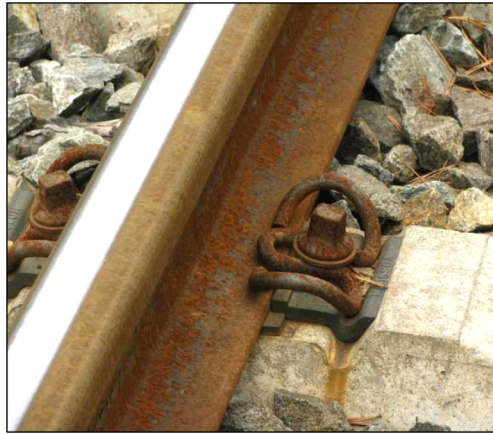
Obr. 18: Příklad přímého pružného upevnění kolejnice (zdroj: [8]).
