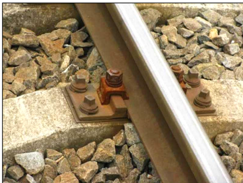
Obr. 17: Příklad nepřímého tuhého upevnění kolejnice (zdroj: [8]).
