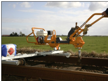
Obr. 20: Utahování vrtulí ruční motorovou zatáčečkou. (zdroj: [10]).
