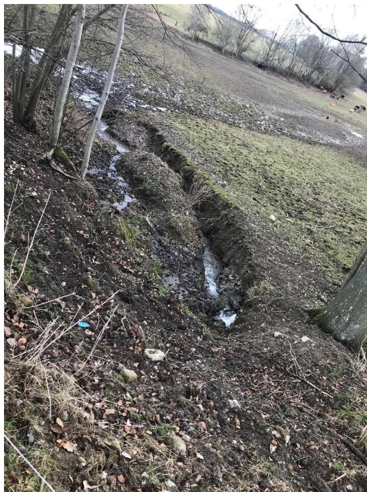
Foto 16 – Nezpevněné koryto spodní výpusti Spodního rybníka
