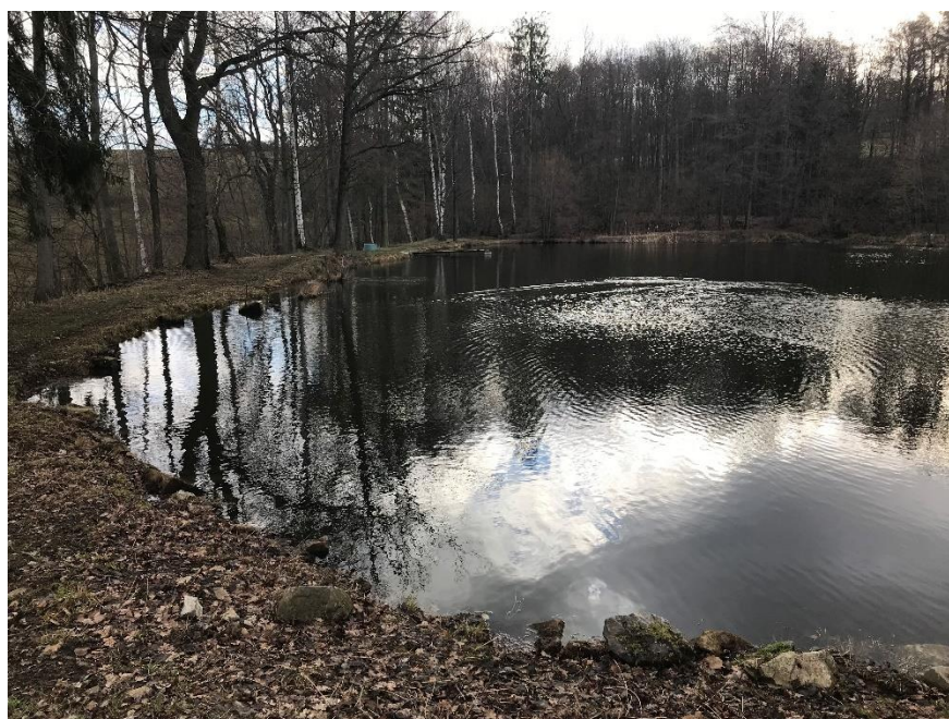
Foto 14 – Pohled na hráz Spodního rybníka
