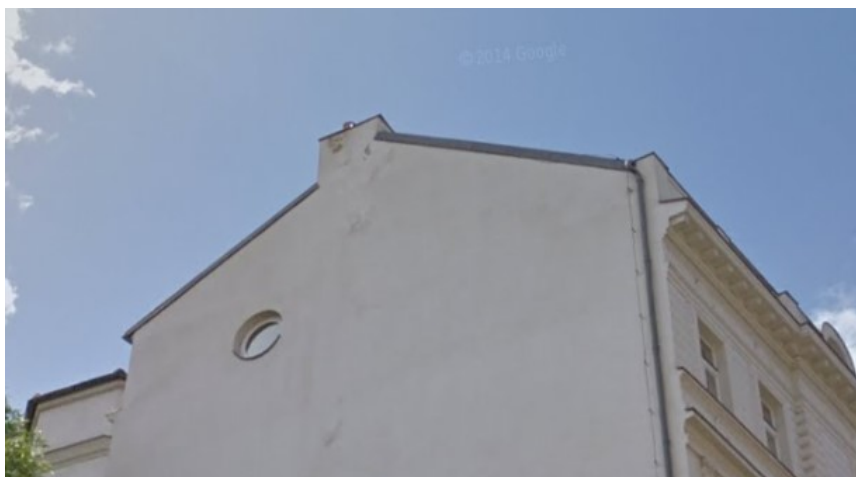
obr. 1 – Okno na sousedním objektu – zdroj. Google Street View – květen 2014
