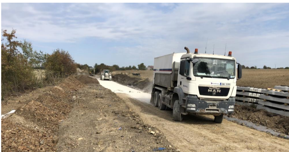
Obr. 11 Dávkovač na podvozku MAN při modernizaci tratě č. 026 [31]
