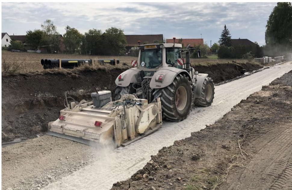
Obr. 15 Zemní fréza při modernizaci tratě č. 026 [31]
