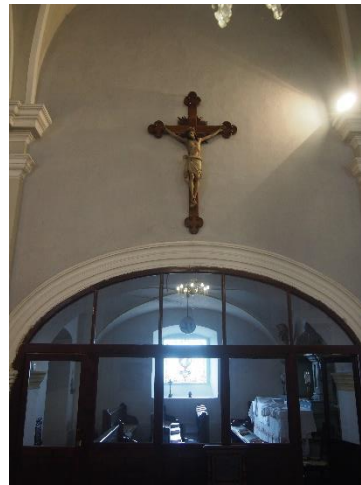
Obrázek 3.28 - Dělicí příčka mezi presbytářem a kaplí
