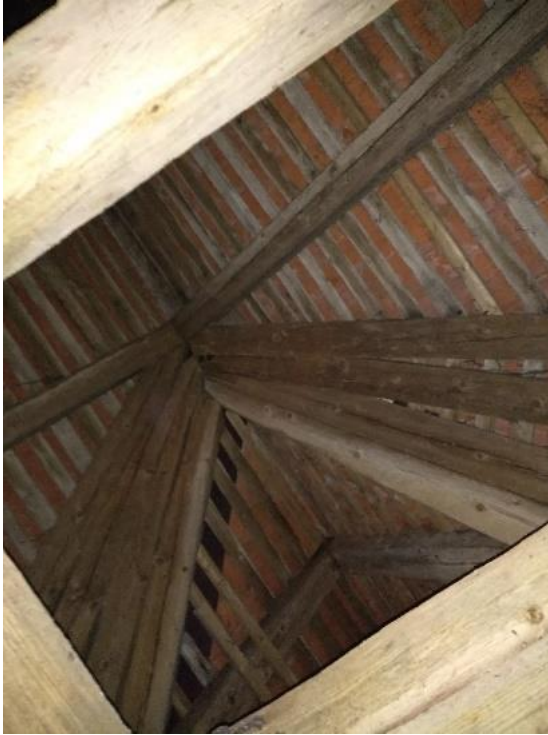
Obrázek 3.22 - Styk krokví v hřebeni a nároží
