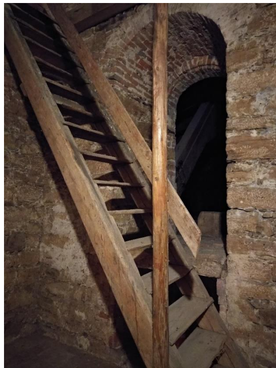
Obrázek 3.38 - Schodiště do krovu věže, vstup do krovu lodi
