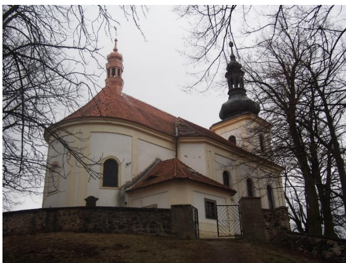
Obrázek 2.2 - Celkový pohled na objekt ze severovýchodní strany
