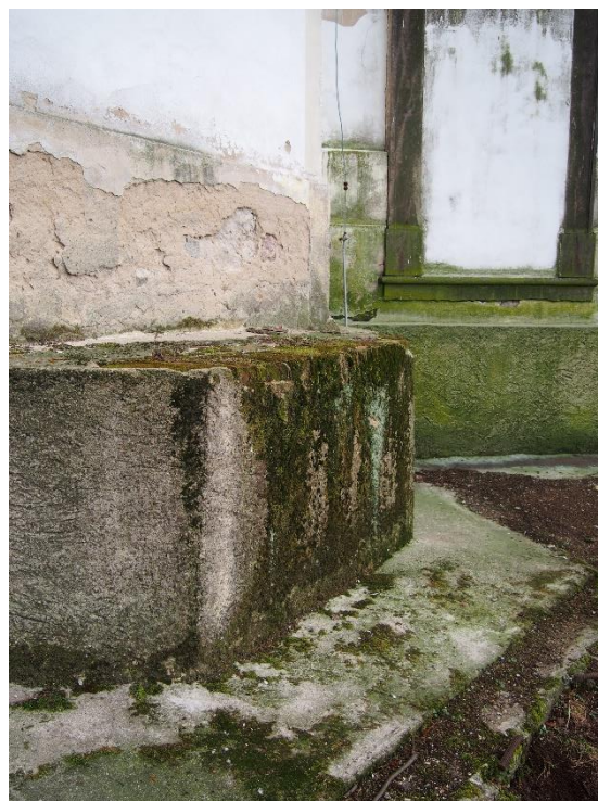
Obrázek 3.2 - Pohled na cihelný sokl pokrytý mechem, severozápadní část
