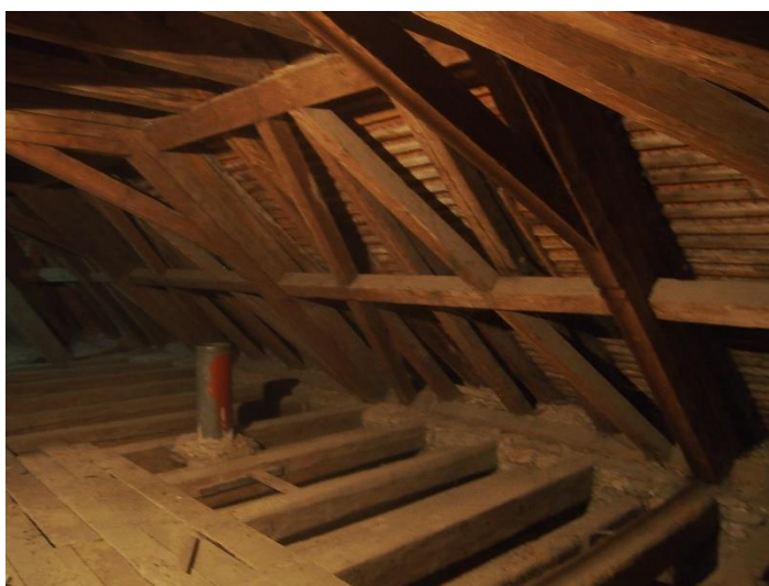
Obrázek 3.20-Pohled na konstrukci krovu, ventilací průduch
