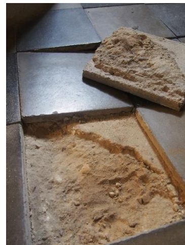
Obrázek 3.35 - Uvolněná dlažba
