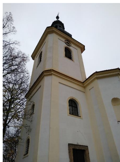
Obrázek 2.3 - Pohled na věž z jihozápadu
