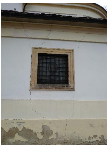
Obrázek 3.10 - Trhliny, kaple
