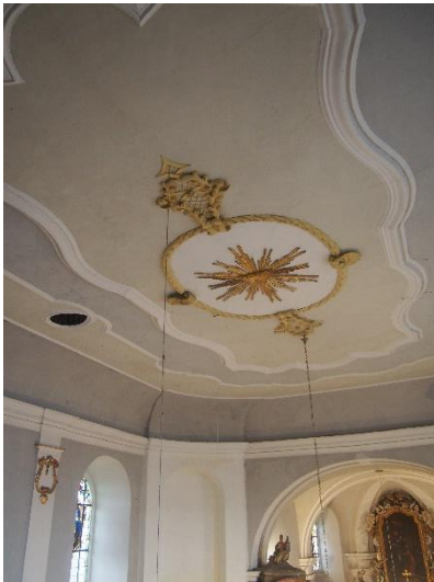
Obrázek 3.12 - Nepravá zrcadlová klenba hlavní lodi
