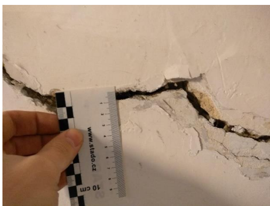
Obrázek 4.27-Trhlina klenby sakristie
