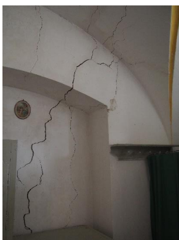
Obrázek 3.9 - Trhliny, sakristie
