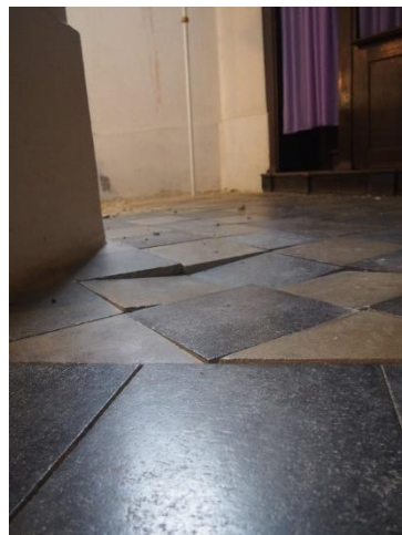
Obrázek 3.34 - Deformace podlahy
