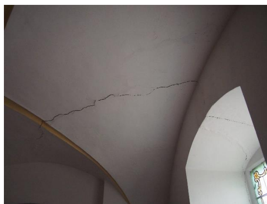
Obrázek 4.28-Trhlina klenby kaple
