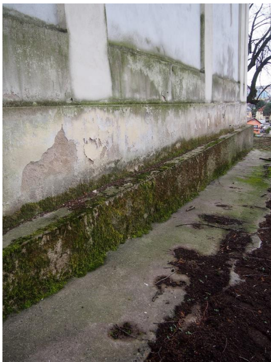
Obrázek 3.1 – Celkový pohled na základy objektu, severní strana
