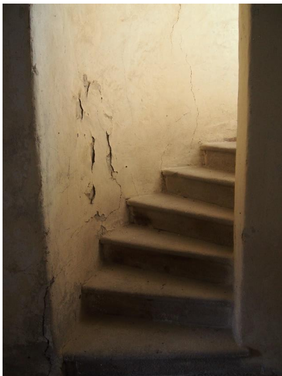
Obrázek 3.37 - Betonové schodiště do věže
