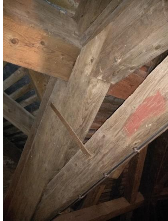
Obrázek 3.23 - Ukázka spojů plné vazby krovu
