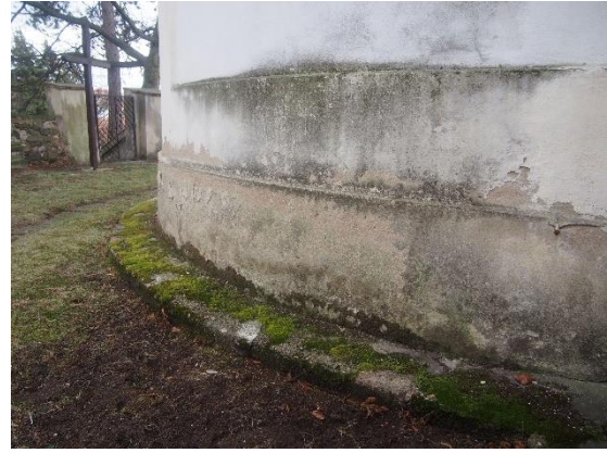
Obrázek 3.31 - Degradace omítek
