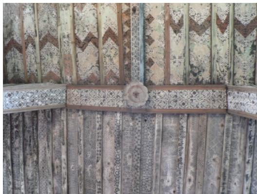
Obrázek 38: pohled na stropní konstrukci
