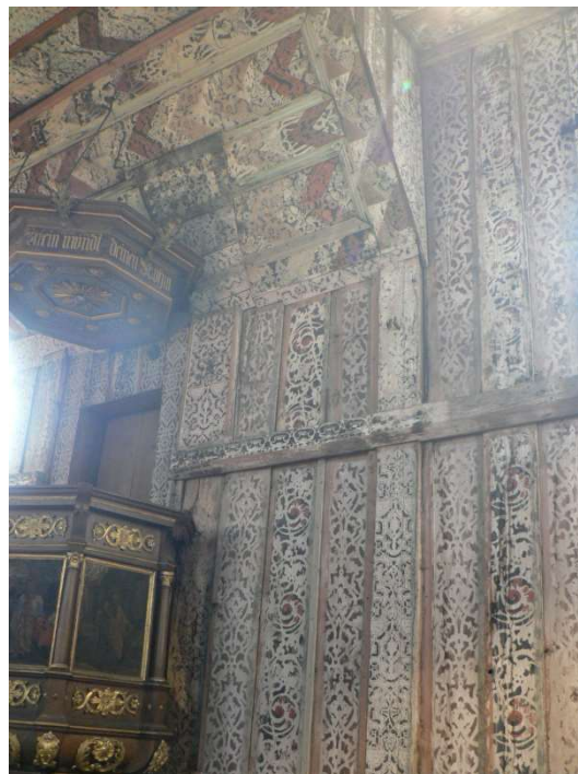
Obrázek 35: pohled na interiérovou stěnu
