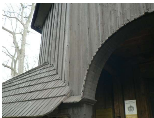
Obrázek 53: detail vstupního portálu
