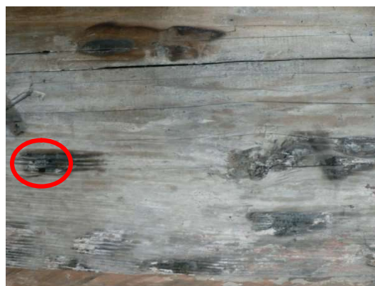
Obrázek 37: napadení prkna tesaříkem trámovým
