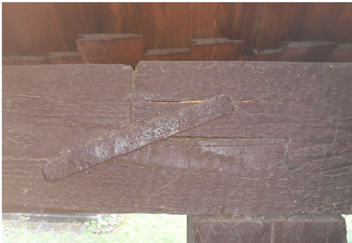
Obrázek 48: délkové napojení střešního trámu ochozu
