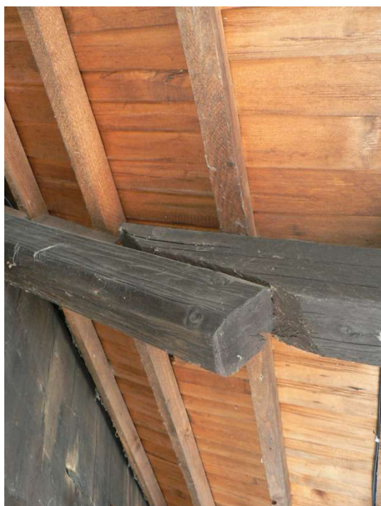
Obrázek 49: délkové napojení střešní krokve
