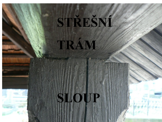
Obrázek 55: pravoúhlé čepování
