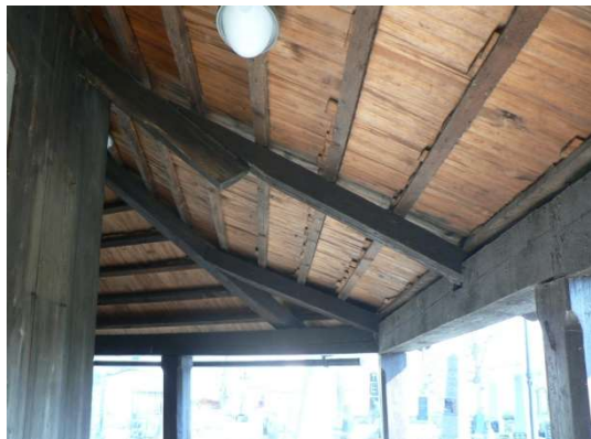
Obrázek 43: pohled na konstrukci střechy ochozu
