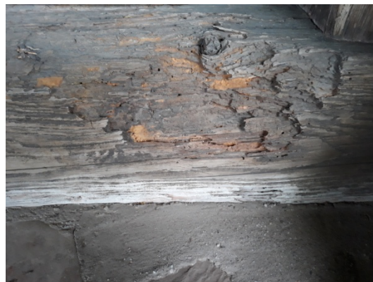
Obrázek 45: protézování prahu zdivem Obrázek 46: napadení prahu tesaříkem trámovým
