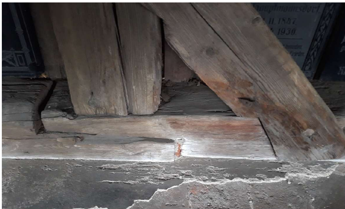
Obrázek 47: napojení prahového trámu v jižní části ochozu
