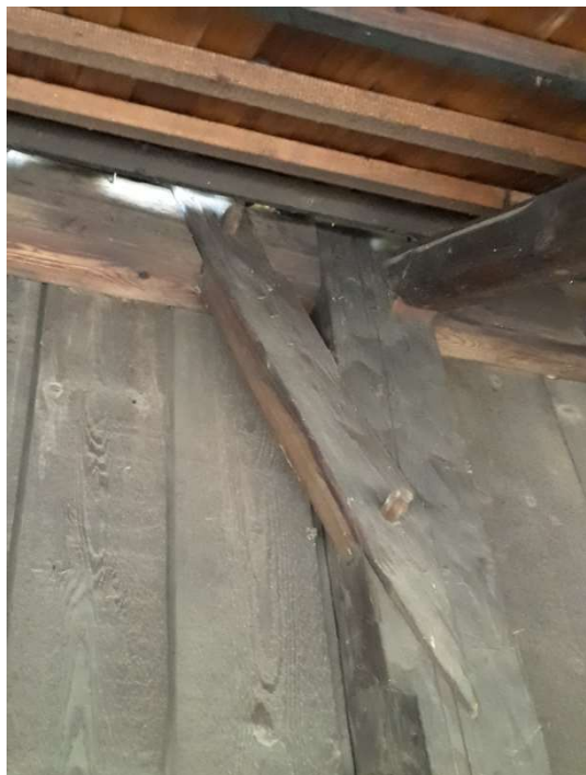
Obrázek 34: pohled na exteriérovou stěnu
