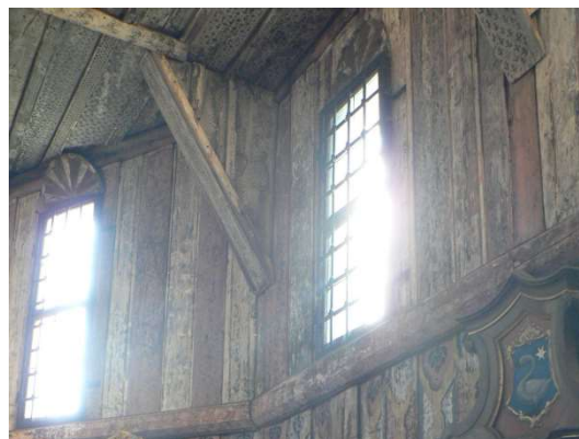
Obrázek 40: okna do interiéru
