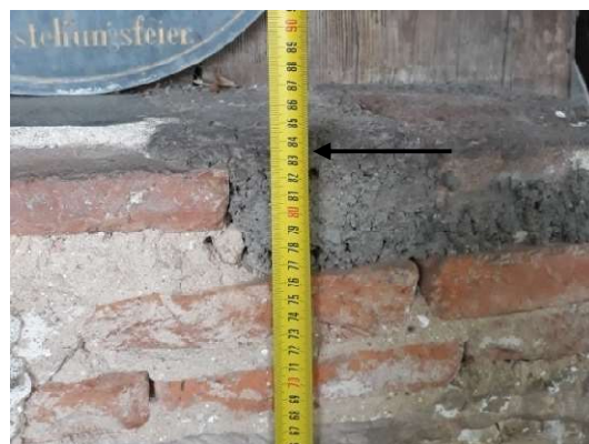
Obrázek 33: měření výšky podezdívky u vstupu do sakristie
