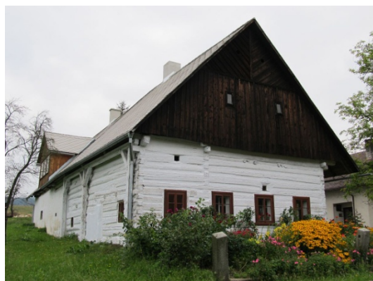
Obrázek 15: nejstarší roubená stavba Rtyně v Podkrkonoší č.p. 53
