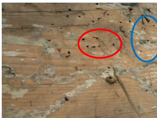
Obrázek 36: napadení dřevokazným hmyzem
