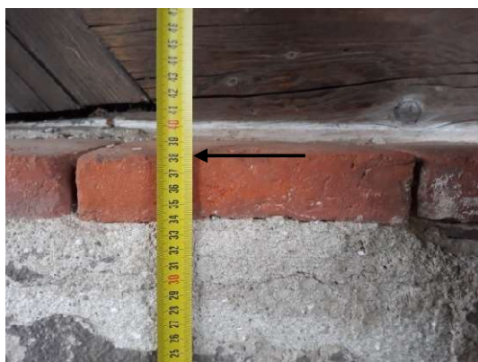
Obrázek 32: měření výšky podezdívky u bočního vchodu
