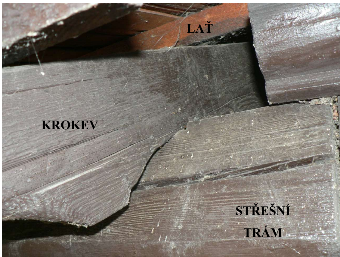
Obrázek 54: osedlání krokve a střešního trámu
