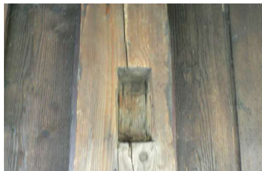
Obrázek 51: otvor ve sloupu
