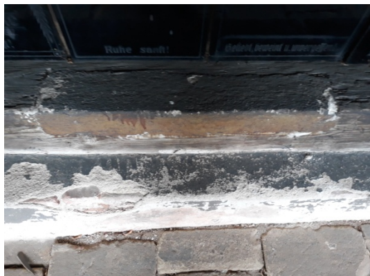
Obrázek 45: protézování prahu zdivem Obrázek 46: napadení prahu tesaříkem trámovým
