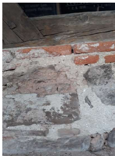
Obrázek 20: příklad podezdívky pro dřevěné konstrukce
