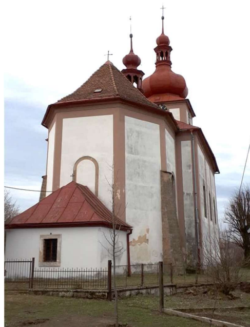
Obr. 12 - Východní pohled, presbytář a sakristie
