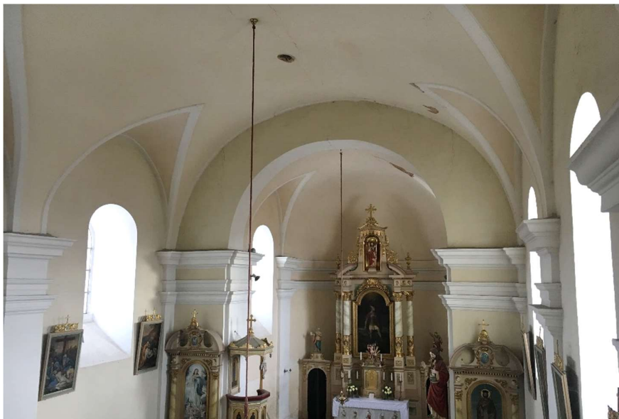
Obr. 23 - Pohled na valenou klenbu a kopuli s lunetami
