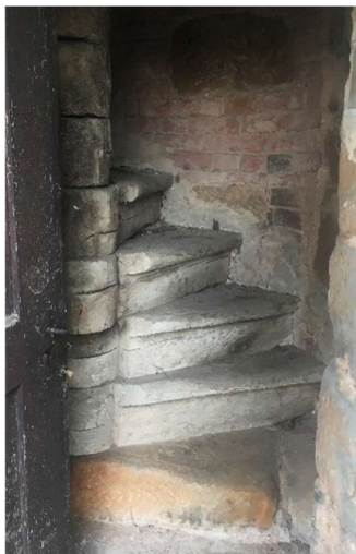
Obr. 24, Obr. 25, Obr. 26 - Schodiště (zleva: kamenné, dřevěné vřetenové točité, dřevěné žebříkové)
