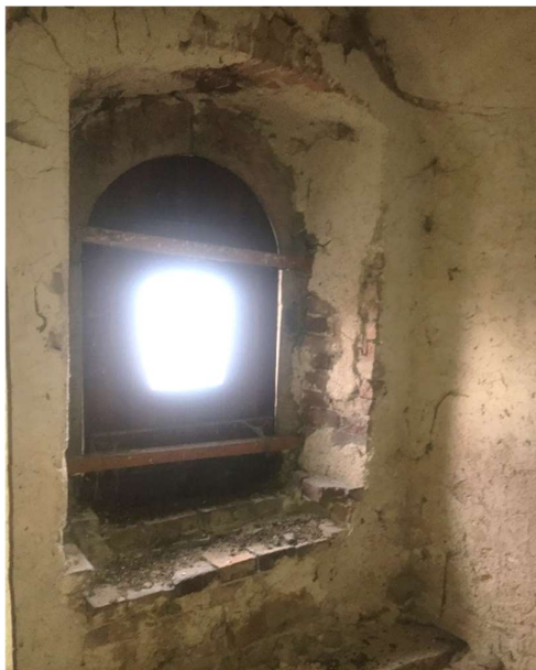
Obr. 17 - Odhalené zdivo u ostění
