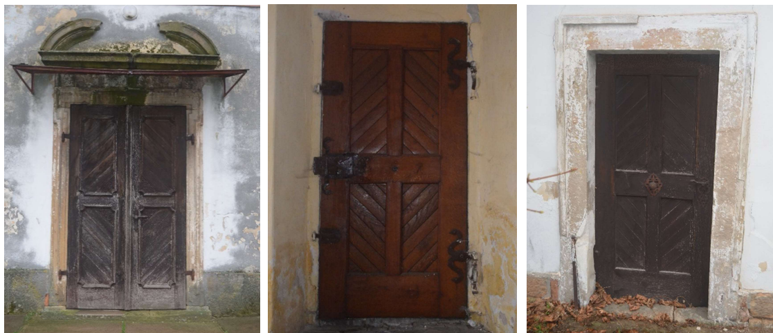
Obr. 33, Obr. 34, Obr. 35 - Dveře (vstupní s kamenným ostěním, vnitřní do sakristie, venkovní do sakristie)
