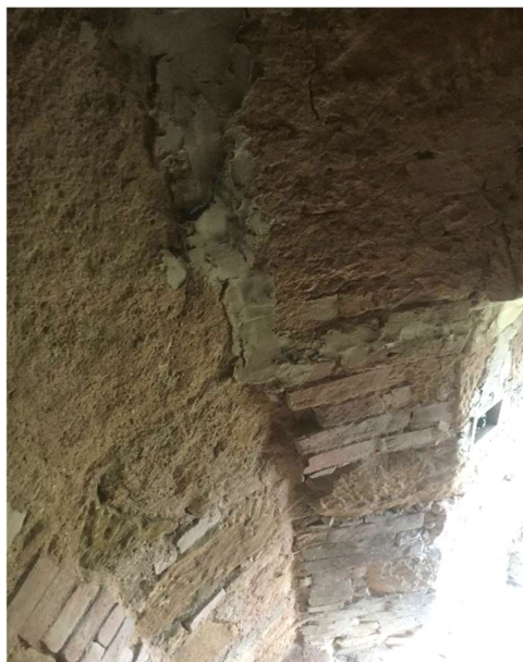
Obr. 18 - Odhalené zdivo v ploše
