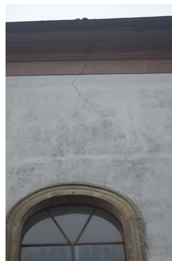
Obr. 59, Obr. 60, Obr. 61 - Svislé trhliny (v oblasti dveřního portálu a oken)
