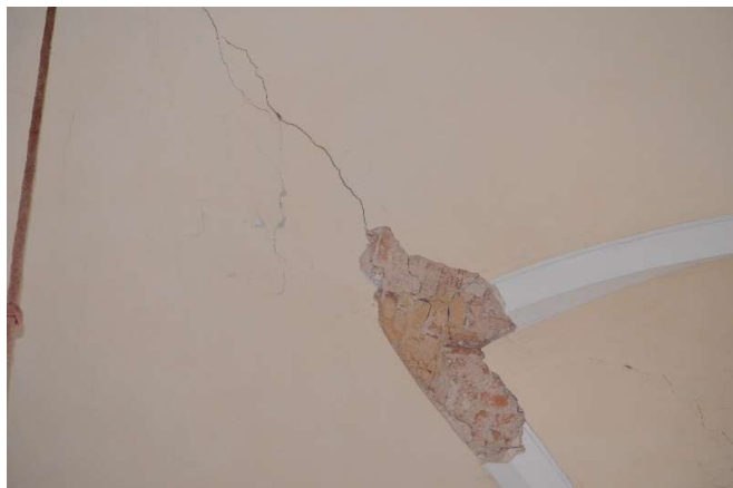
Obr. 62, Obr. 63 - Vodorovné trhliny (vrchol lunety, klenba nad oknem)
