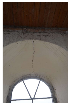
Obr. 62, Obr. 63 - Vodorovné trhliny (vrchol lunety, klenba nad oknem)
