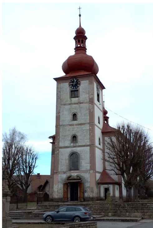
Obr. 11 - Západní pohled, věž a vstupní portál
