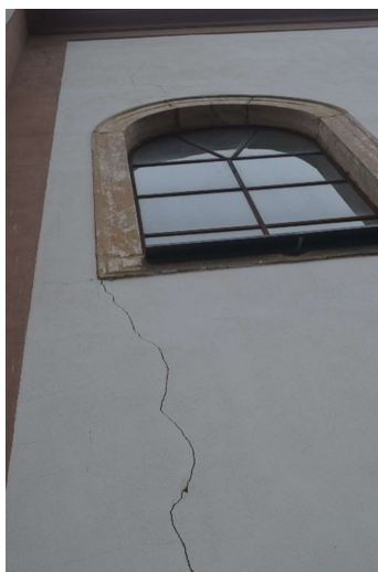
Obr. 59, Obr. 60, Obr. 61 - Svislé trhliny (v oblasti dveřního portálu a oken)
