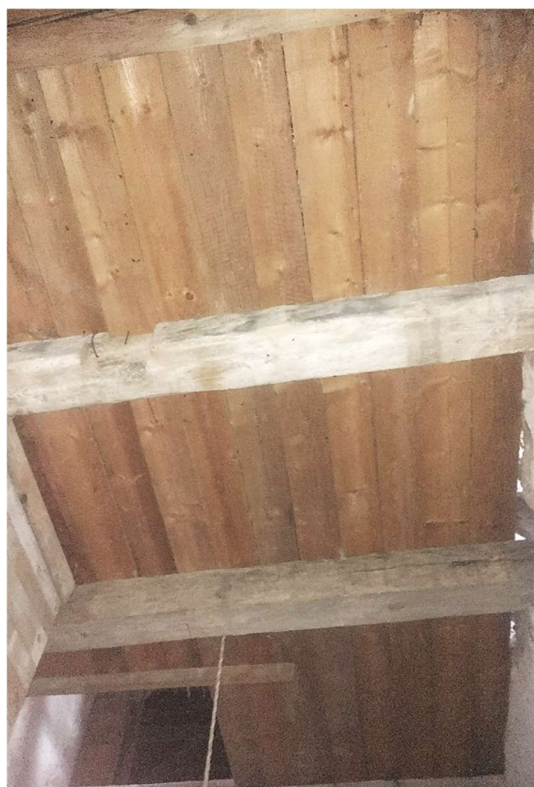
Obr. 22 - Dřevěný trémový strop ve věži
