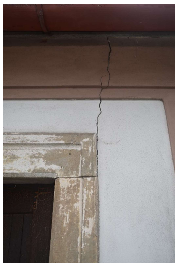
Obr. 59, Obr. 60, Obr. 61 - Svislé trhliny (v oblasti dveřního portálu a oken)
