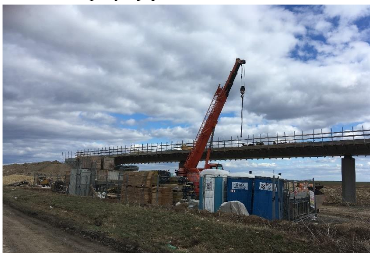
Obrázek 23 Stanoviště jeřábu (Zdroj autor)
