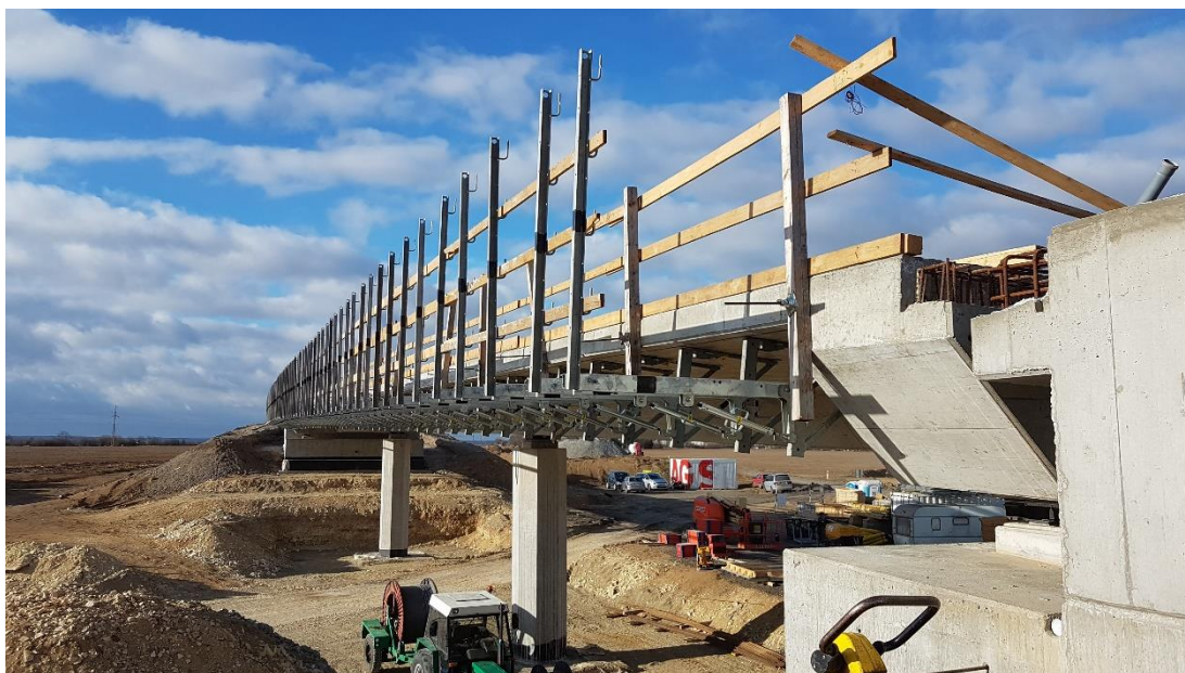
Obrázek 15 Zábradlí ve výstavbě (Zdroj autor)
