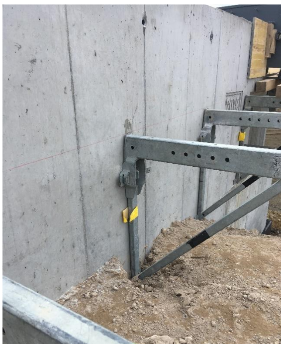
Obrázek 14 Pevně přichycené zábradlí ke konstrukci (Zdroj autor)
