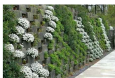
ŽIVÁ OPĚRNÁ STĚNA
