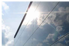
FV PANELY - STŘECHA/FASÁDA
