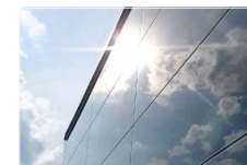
FV PANELE - STŘECHA/FASÁDA
