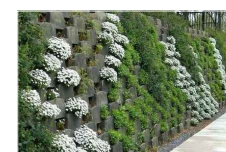
ŽIVÁ OPĚRNÁ STĚNA
