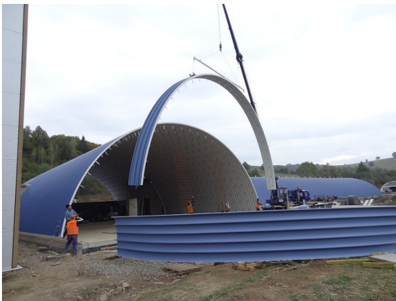
Obrázek 26: Montáž samonosných oblouků (převzato z [10])
