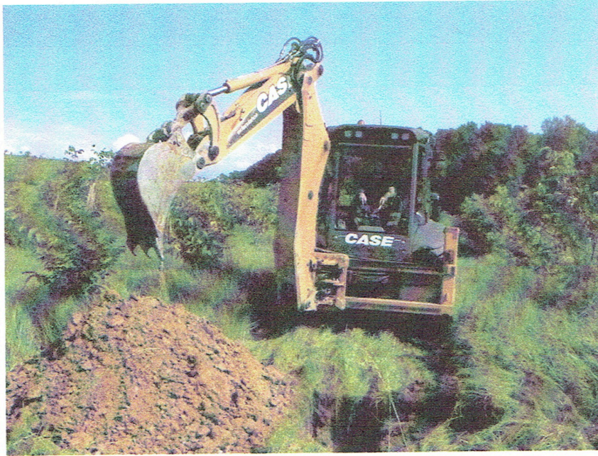
Sonda K8 na pravém břehu ve svahových hlínách.
