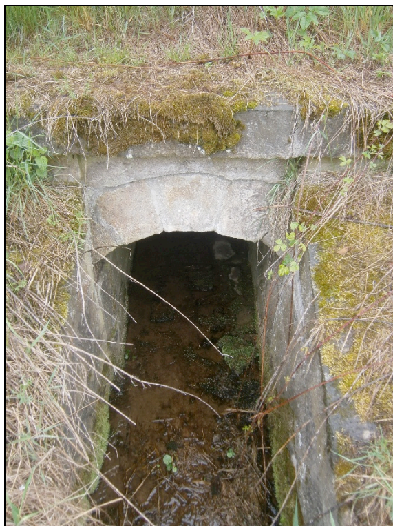
Obr. 15 Klenbový propustek pohled po vodě
