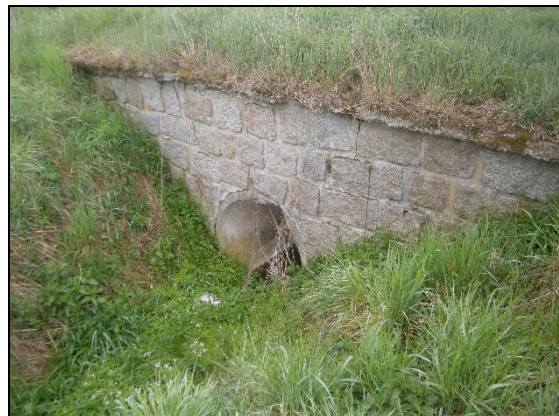
Obr. 14 Propustek DN 1000 po vodě
