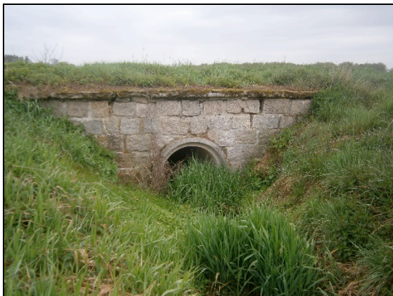
Obr. 13 Propustek DN 1000 proti vodě
