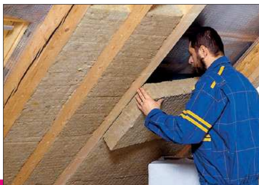
Ukázka aplikace výrobku Isover UNI
