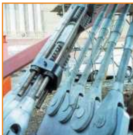
Zařízení TechnoTensioner na londýnském mostě Millennium Bridge, VB
