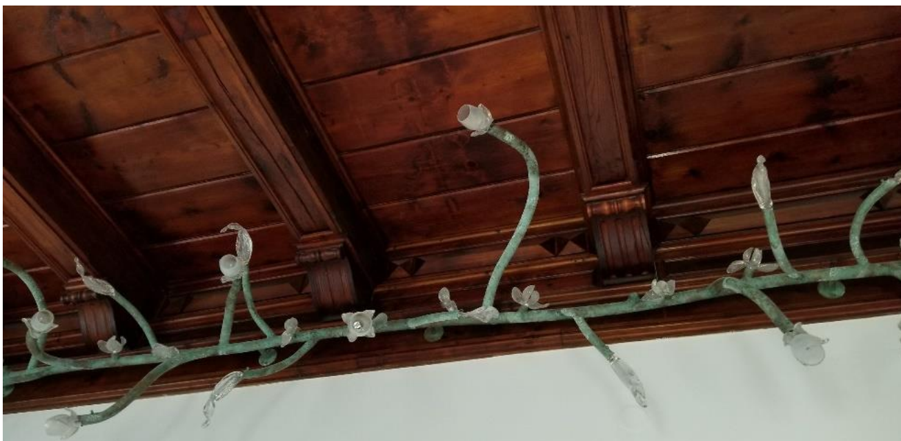
Obrázek č. 5, trámový strop v místnosti 1.04
