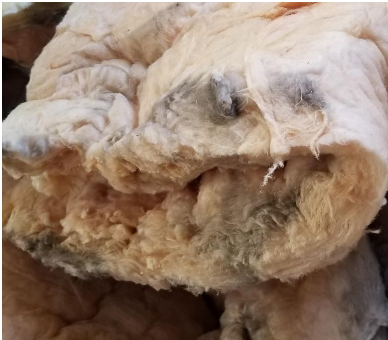
Obrázek č. 7, minerální vata ve střešním plášti
