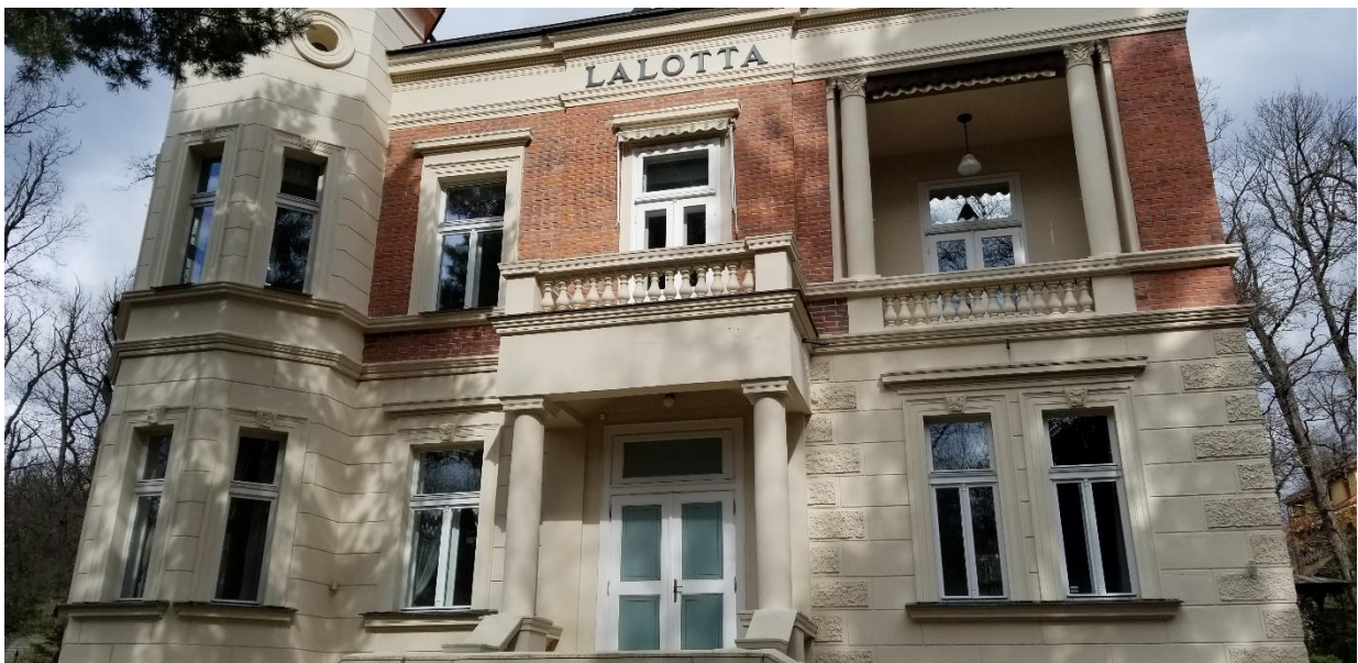
Obrázek č. 4, jižní pohled
