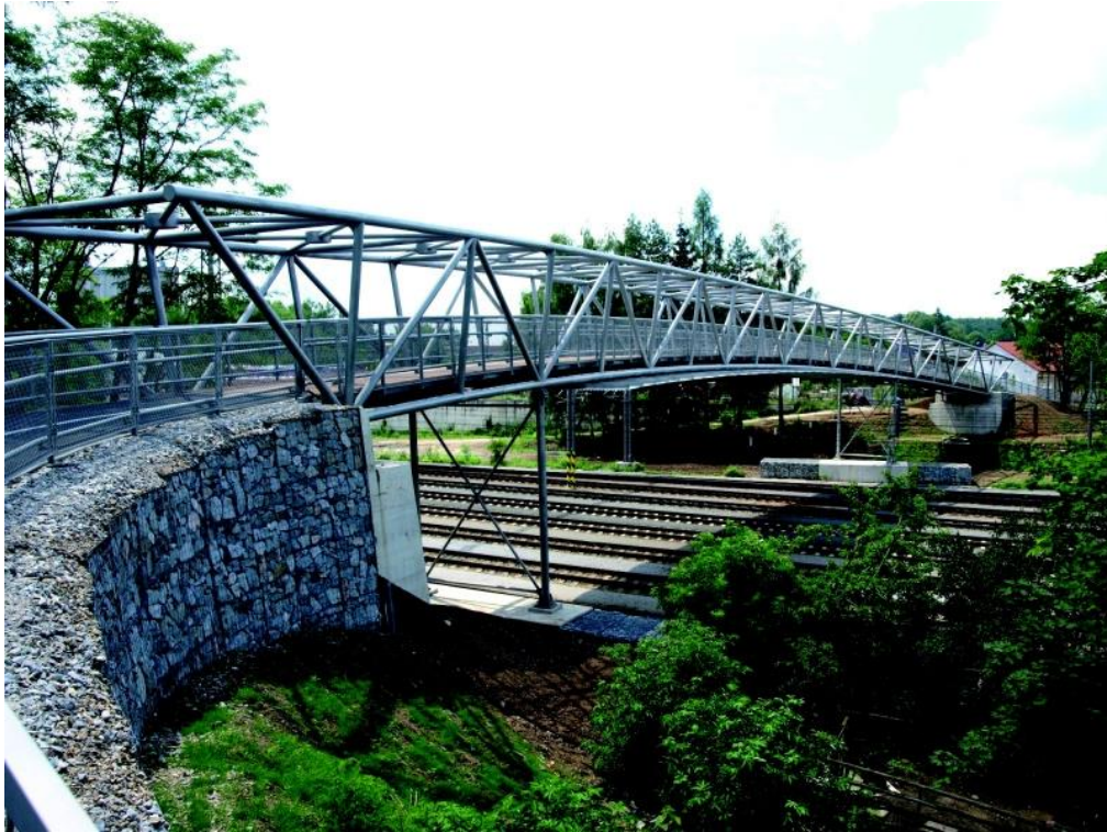
Obr. 1.2 Boční pohled na lávku [17]
