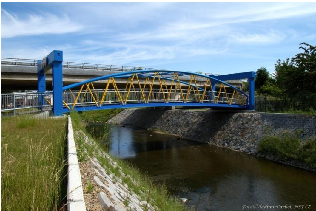
Obr. 1.5 Boční pohled na lávku [18]
