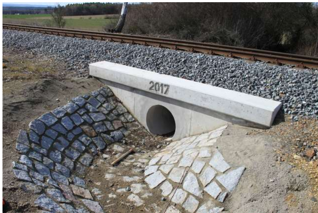
Obr. 50: Zrekonstruovaný propustek km 12,180
