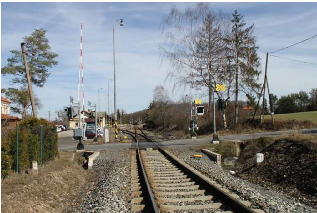
Obr. 52: Přejezd P5754, km 14,711, pohled do žst. Mníšek pod Brdy ve směru staničení
