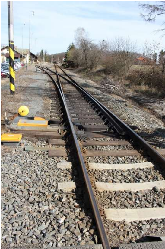
Obr. 53: Výhybka 6°, žst. Mníšek pod Brdy, pohled ve směru staničení, zhlaví
