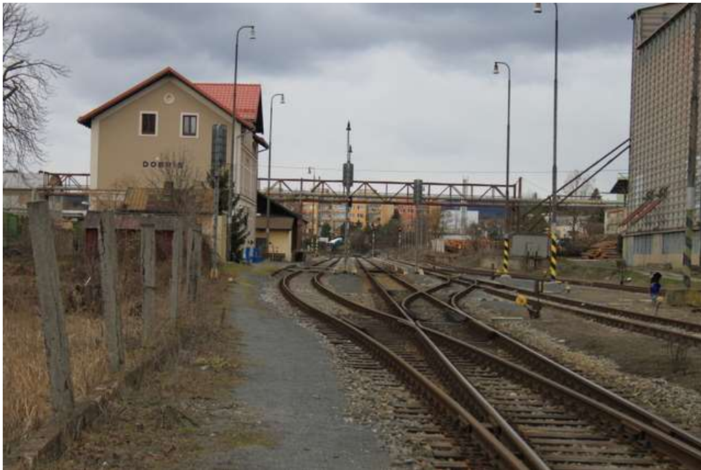
Obr. 1: Žst. Dobříš, zhlaví, výpravní budova, proti směru staničení
