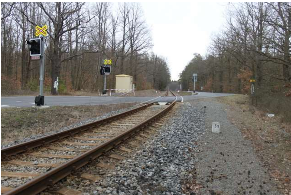
Obr. 10: Přejezd P5739 km 3,521, pohled ve směru staničení
