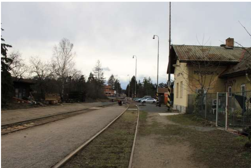
Obr. 54: Žst. Mníšek pod Brdy, pohled proti směru staničení
