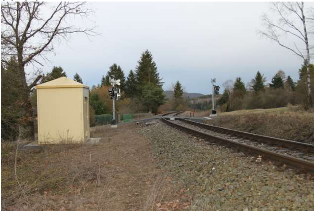
Obr. 24: Přejezd P5744 km 6,830, ve směru staničení
