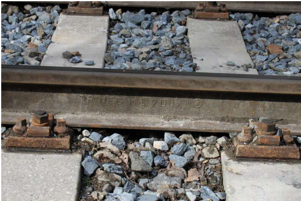
Obr. 51: Kolejnice typu T, km 13,600
