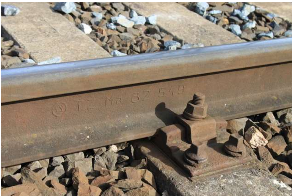
Obr. 32: Kolejnice S49, km 8,400
