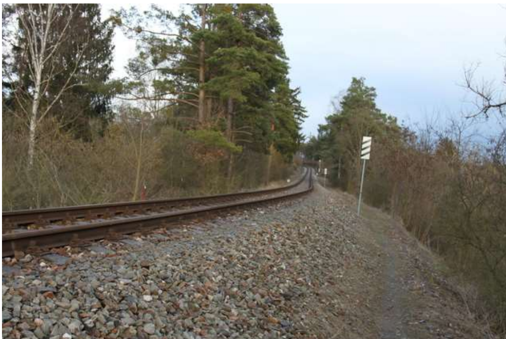
Obr. 25: Pohled na trať km 7,000, ve směru staničení
