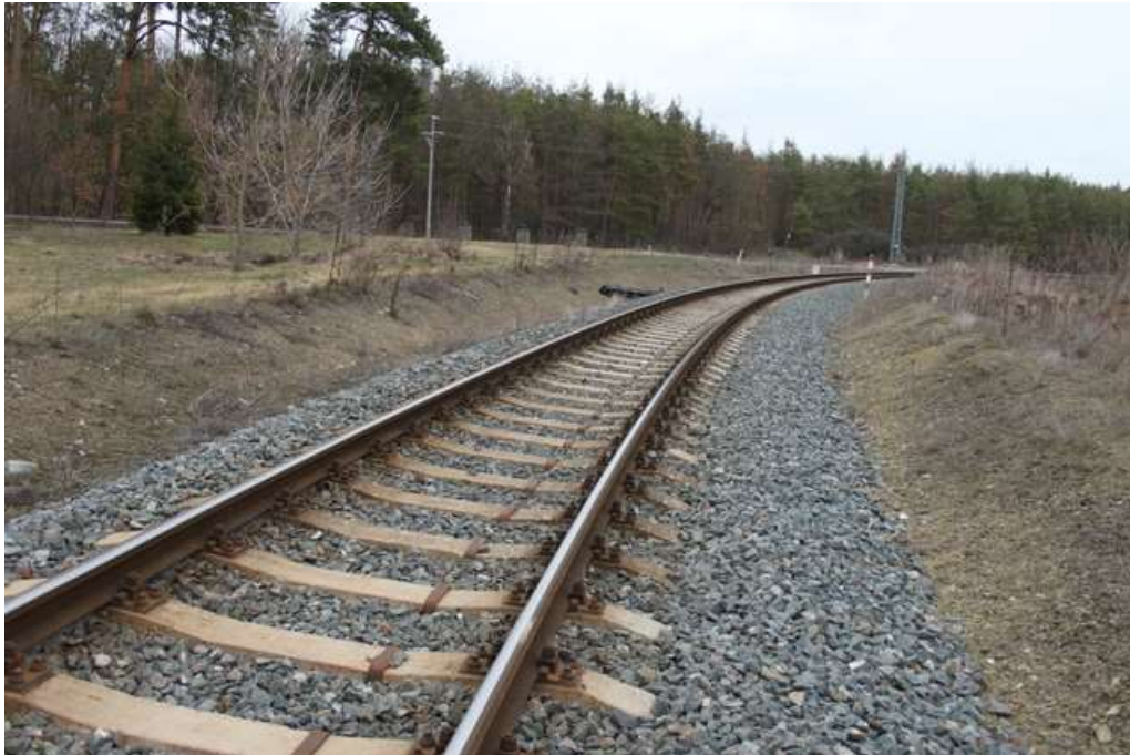
Obr. 9: Pohled ve směru staničení, km 2,600
