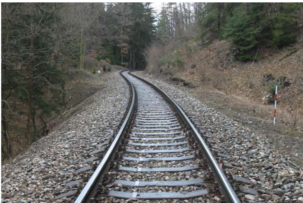
Obr. 22: Protisměrné směrové oblouky km 6,300 – ve směru staničení
