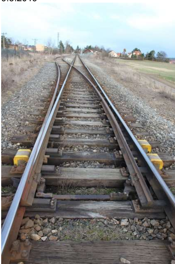
Obr. 28: Výhybka 6°, pohled do žst. Malá Hraštice, ve směru staničení
