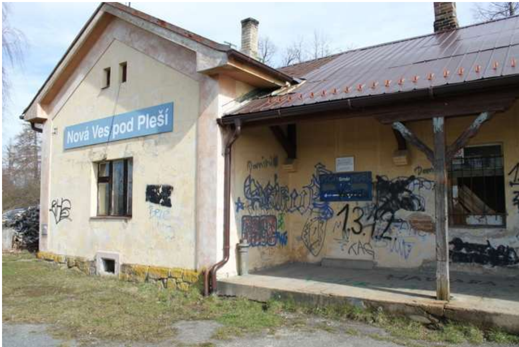
Obr. 43: Z. Nová Ves pod Pleší, výpravní budova
