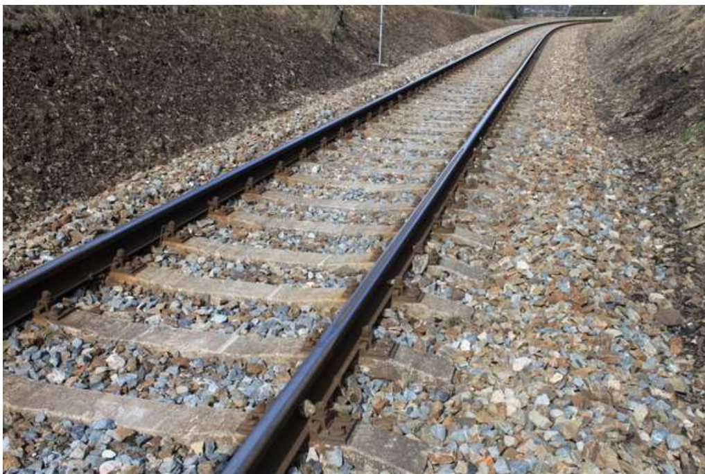
Obr. 33: Trať km 9,000, ve směru staničení
