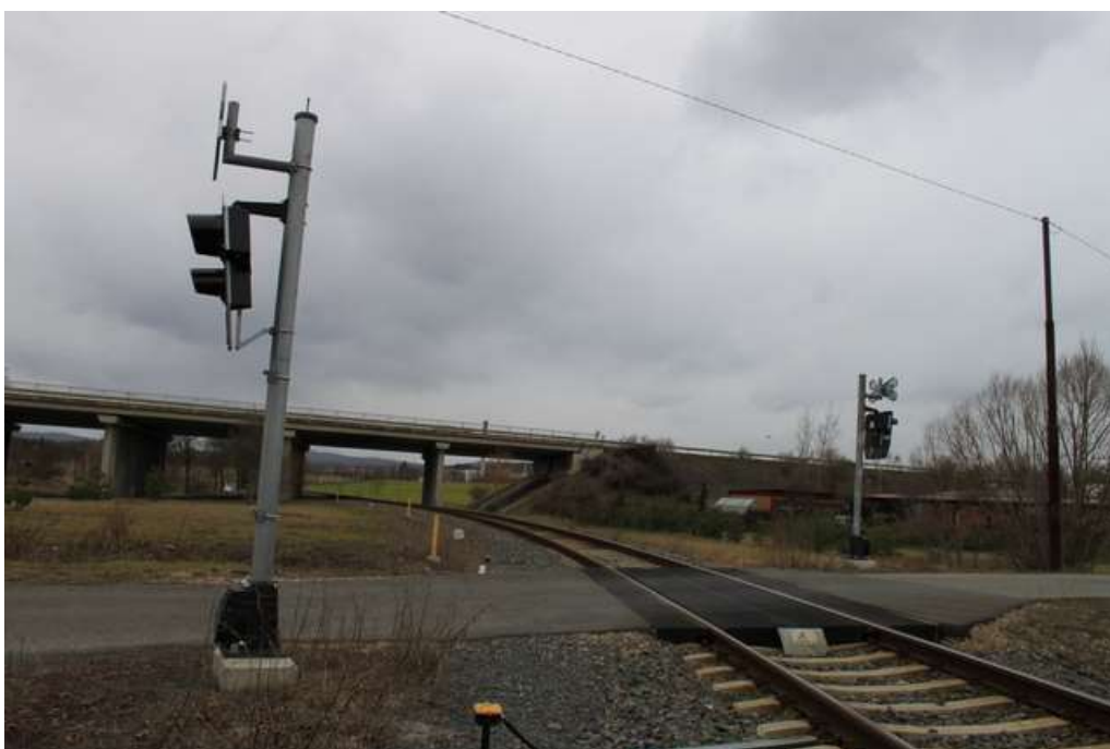
Obr. 6: Nadjezd km 1,013, přejezd P5732, km 1,120, proti směru staničení
