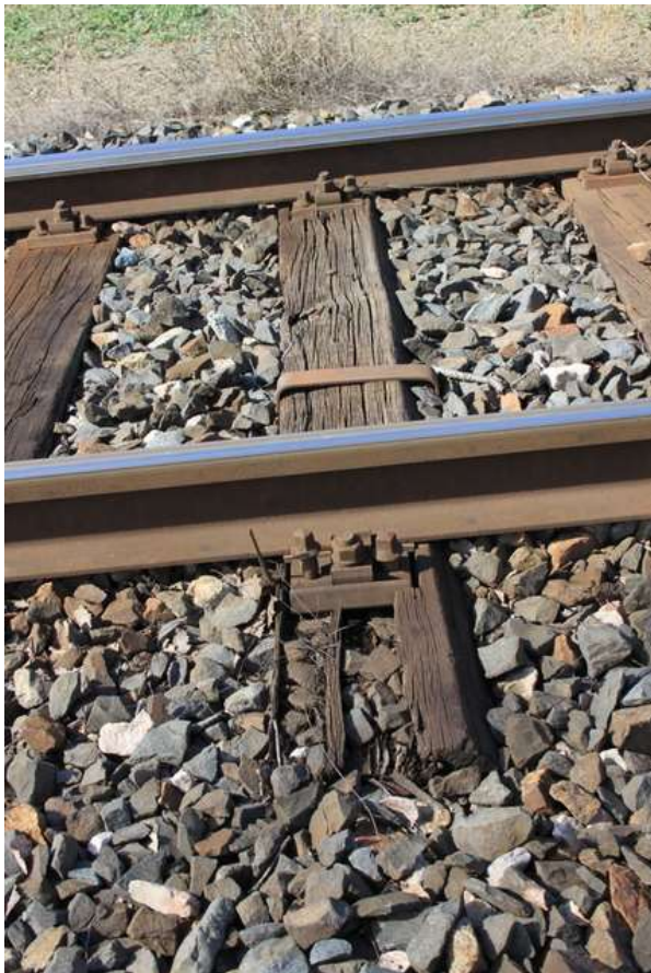
Obr. 49: Stav dřevěných pražců, km 12,000
