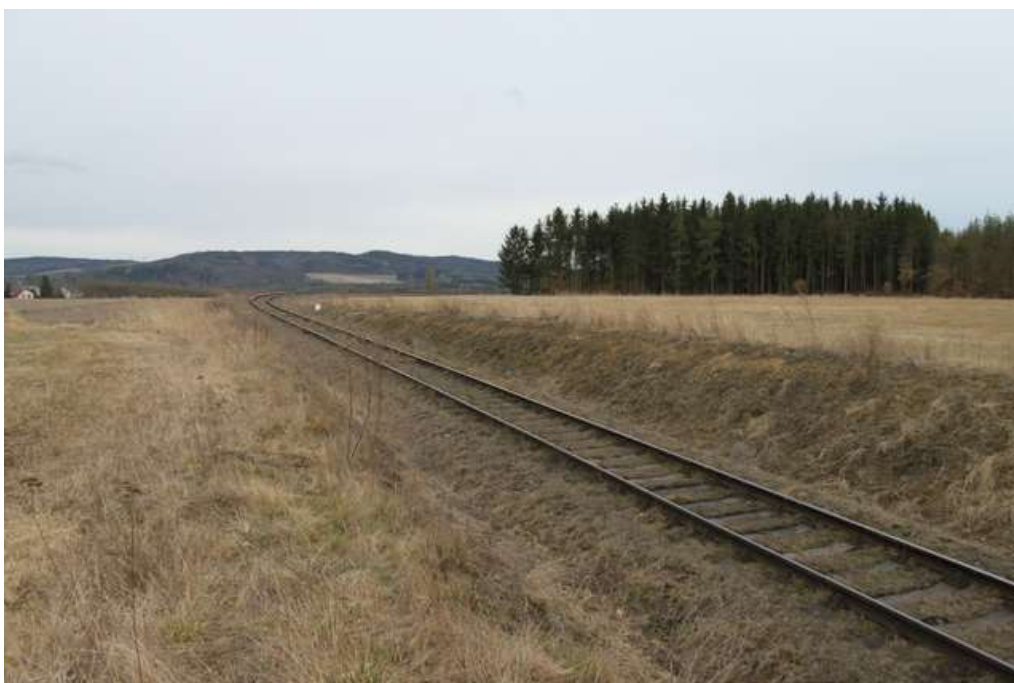
Obr. 18: Směrový oblouk km 5,400 – proti směru staničení
