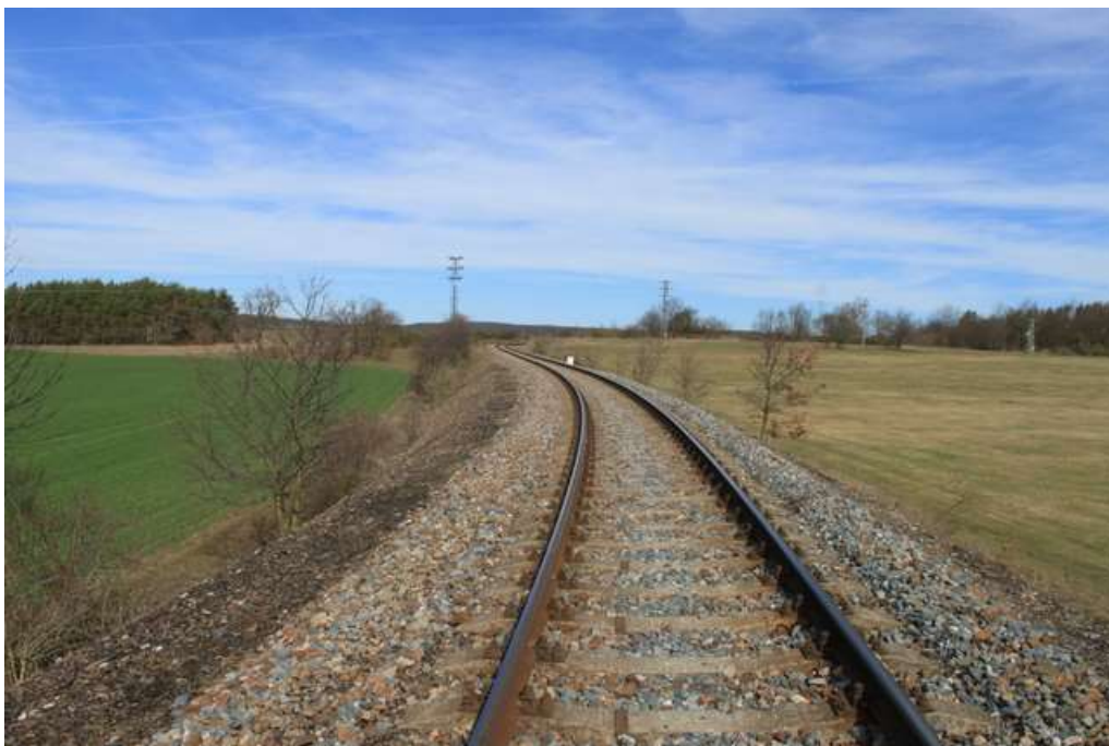
Obr. 35: Trať km 9,400, ve směru staničení
