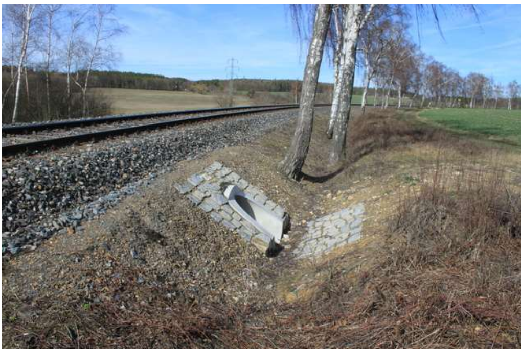
Obr. 47: Zrekonstruovaný propustek, km 11,730
