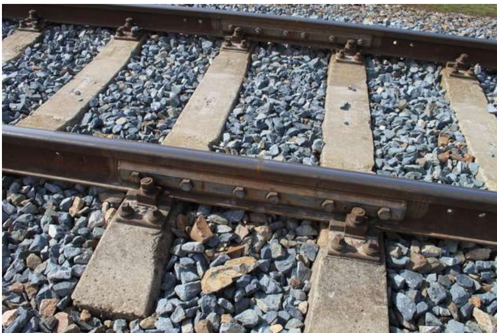
Obr. 38: Izolovaný styk km 10,200
