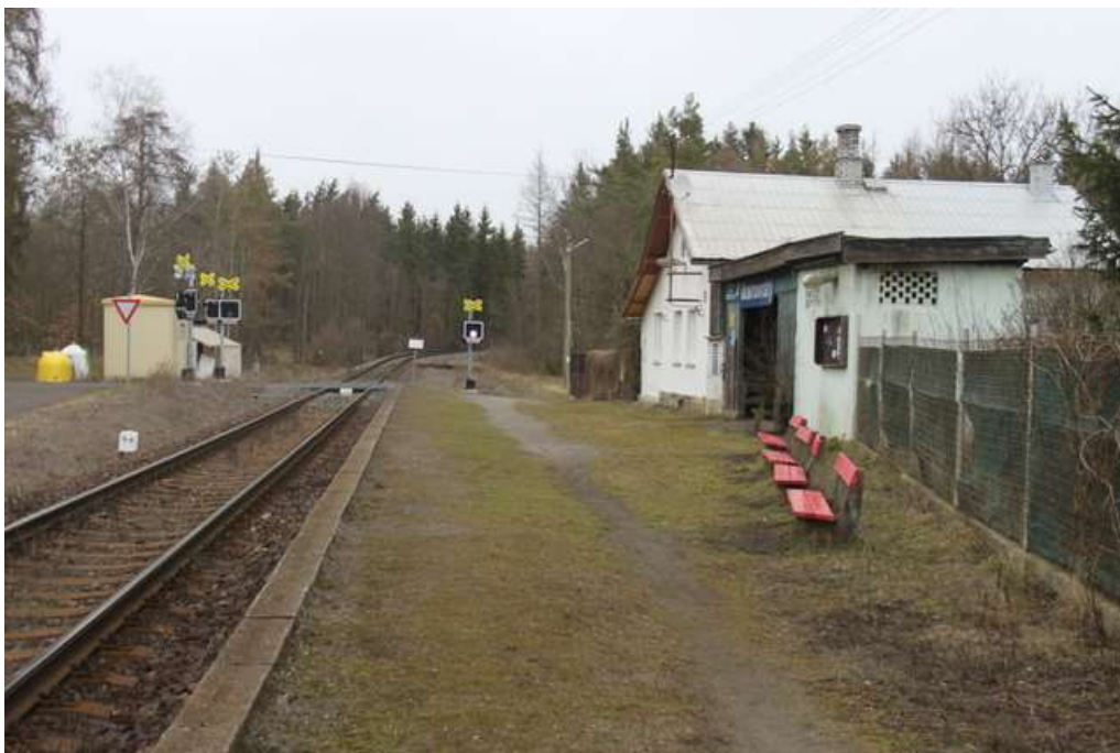
Obr. 15: Z. Mokrovraty, přejezd P5742 km 4,829, pohled ve směru staničení
