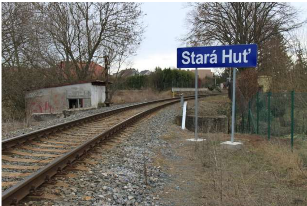
Obr. 7: Stará drážní studna, km 1,160
