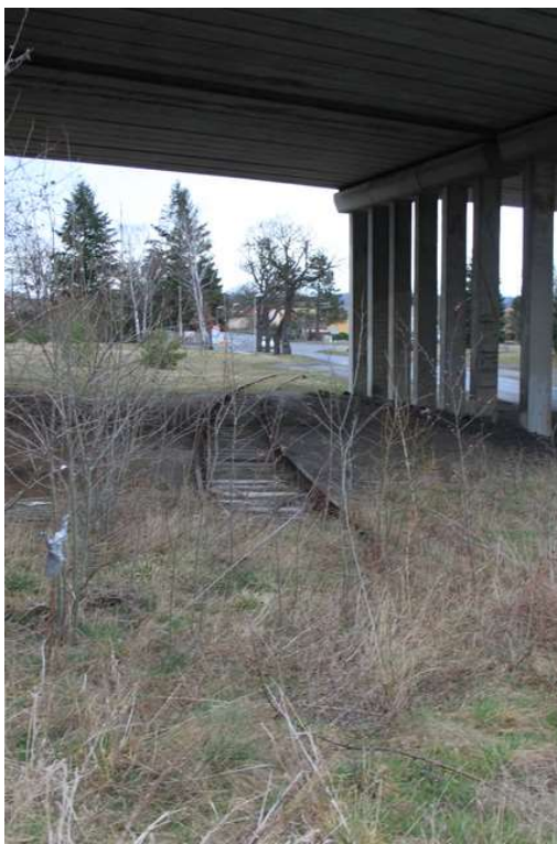
Obr. 5: Zrušená vlečka (odstavná kolej), km 0,900
