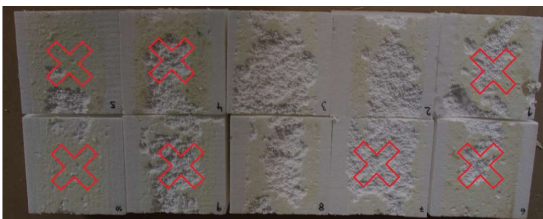
Obr. 38 - - Porušení vzorků tepelné izolace s vyznačením neplatných vzorků, uspořádání odpovídá předešlým fotkám (zdroj autor)
