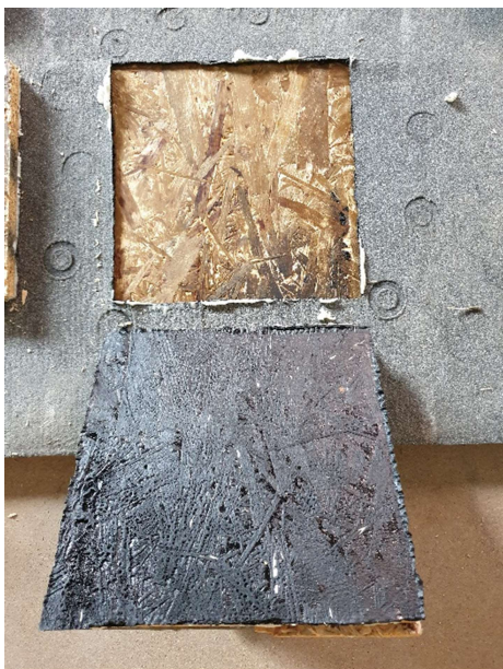
Obr. 32 - Provedená odtrhová zkouška asfaltového pásu (zdroj autor)
