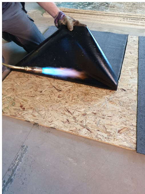
Obr. 16 - Natavování asfaltového pásu (zdroj autor)
