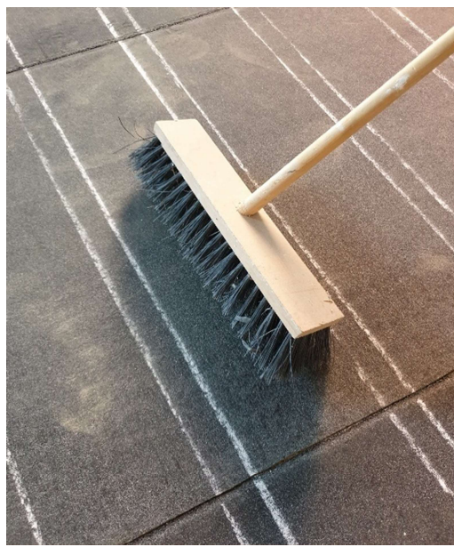
Obr. 19 - Zbavení povrchu nečistot (zdroj autor)
