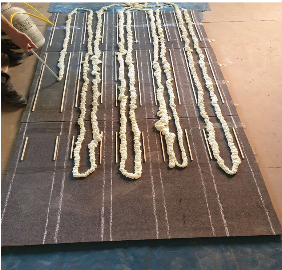
Obr. 23 - - Nanášení lepidla (zdroj autor)
