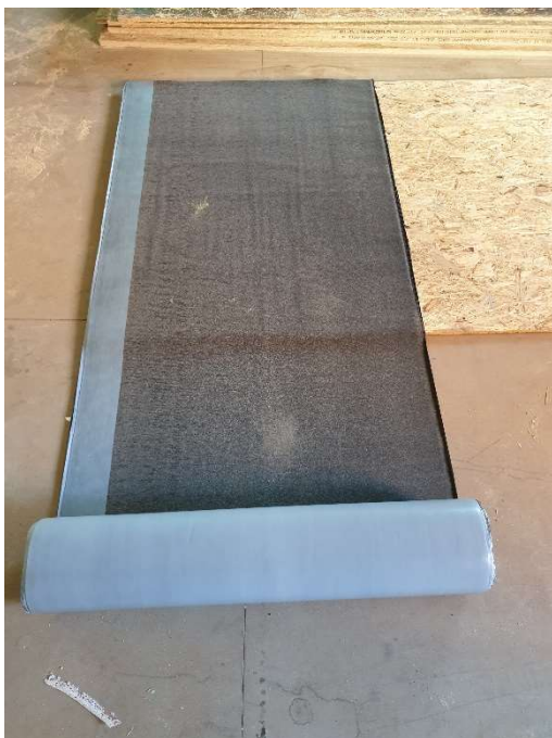
Obr. 15 - připravený asfaltový pás (zdroj autor)
