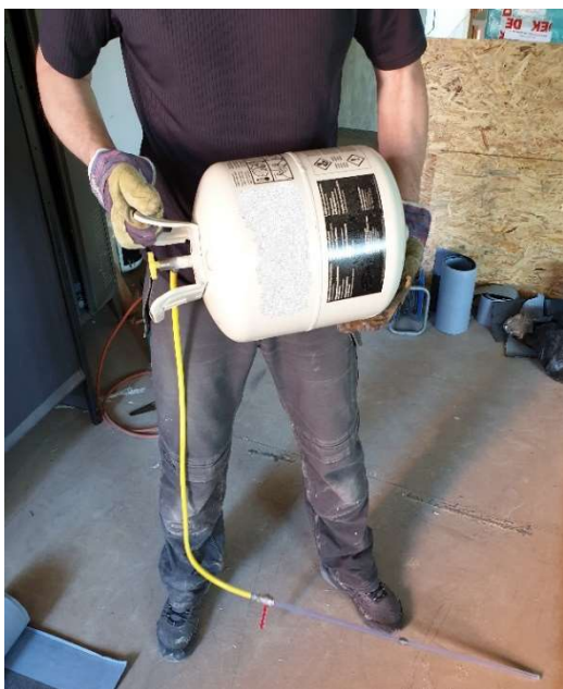
Obr. 22 - Protřepání nádoby před použitím (zdroj autor)
