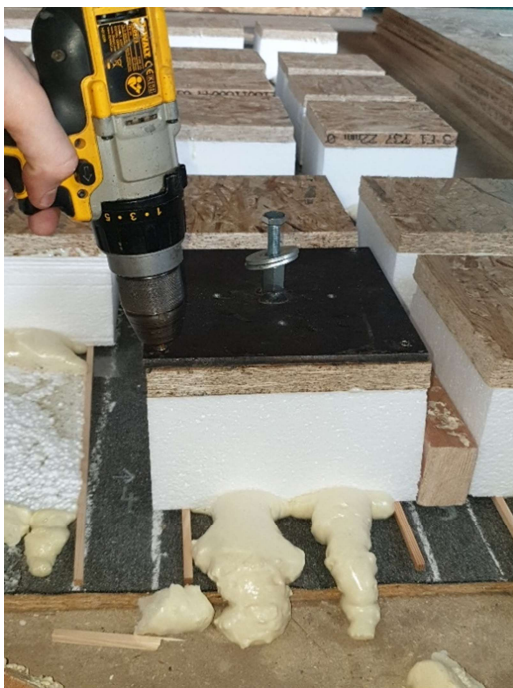
Obr. 30 - Připevnění ocelového plátu (zdroj autor)
