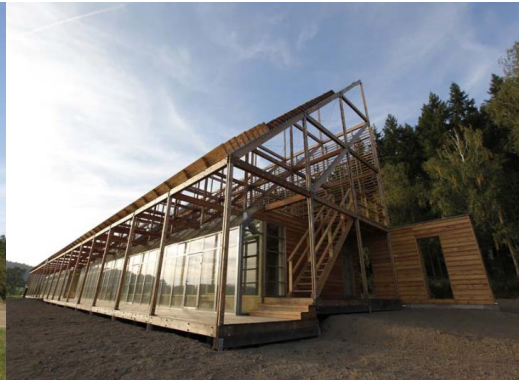
Obrázek 14 - Dřevostavba Písek - II
