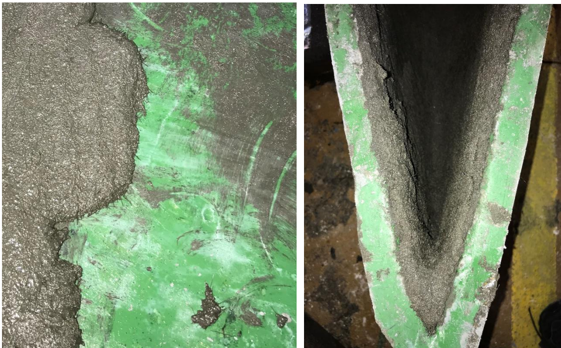
Obr. 7.2 - Detail betonové směsi ve formě při betonáži (vlevo), detail vybetonované přídě (vpravo)
