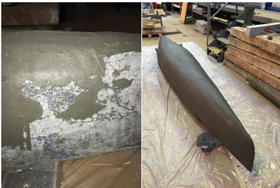
Obr. 7.8 - Nanášení cementové stěrky (vlevo) a loď se stěrkou nanesenou po celém vnějším povrchu (vpravo)
