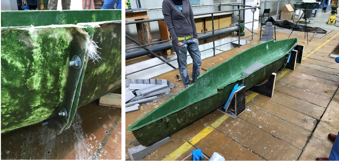
Obr. 7.1 - Detail šroubového spojení dílů bednění (vlevo), finální složená a podepřená forma (vpravo)
