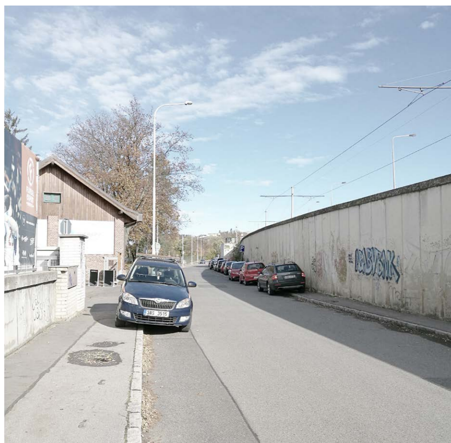
POHLED OD BRANICKÉ VODÁRNY NA ÚROVŇOVÉ TRAMVAJOVÉ TĚLESO
