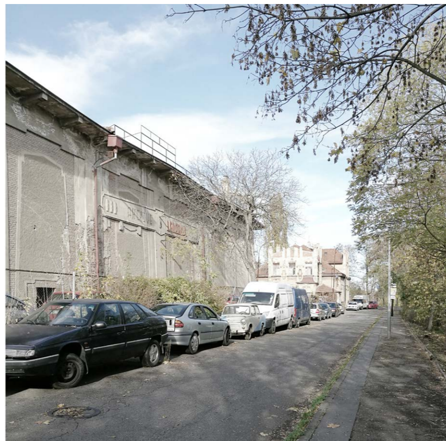
AREÁL BRANICKÝCH LEDÁREN - BÝVALÁ LEDNICE A VILA SPRÁVCE
