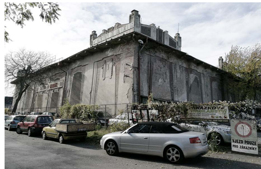
AREÁL BRANICKÝCH LEDÁREN - BÝVALÁ LEDNICE
