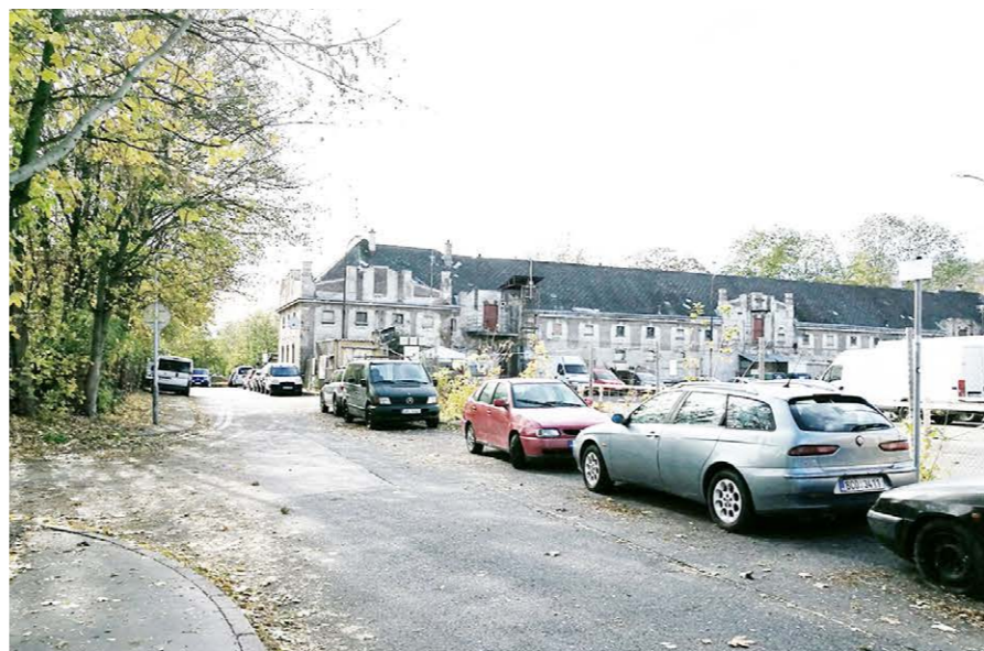
AREÁL BRANICKÝCH LEDÁREN - BÝVALÁ BUDOVA STÁJÍ
