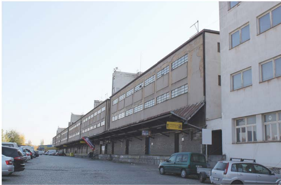
severní fasáda Nákladového nádraží
