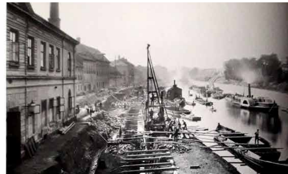
fotografie z r. 1893, přestavba Karlínského přístavu
