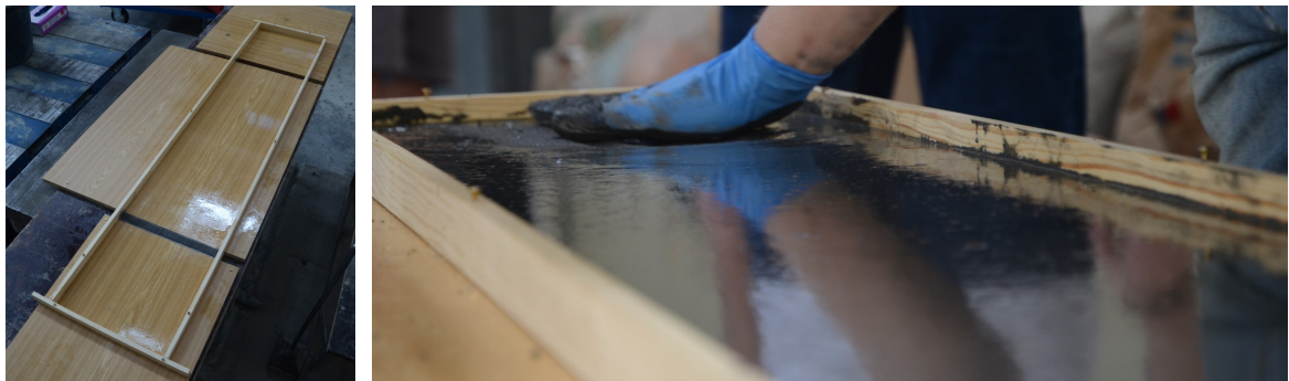
Obrázek 37: Betonáž mostovky v dílnách FSv
