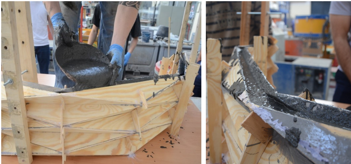
Obrázek 36: Betonáž oblouku v dílnách FSv
