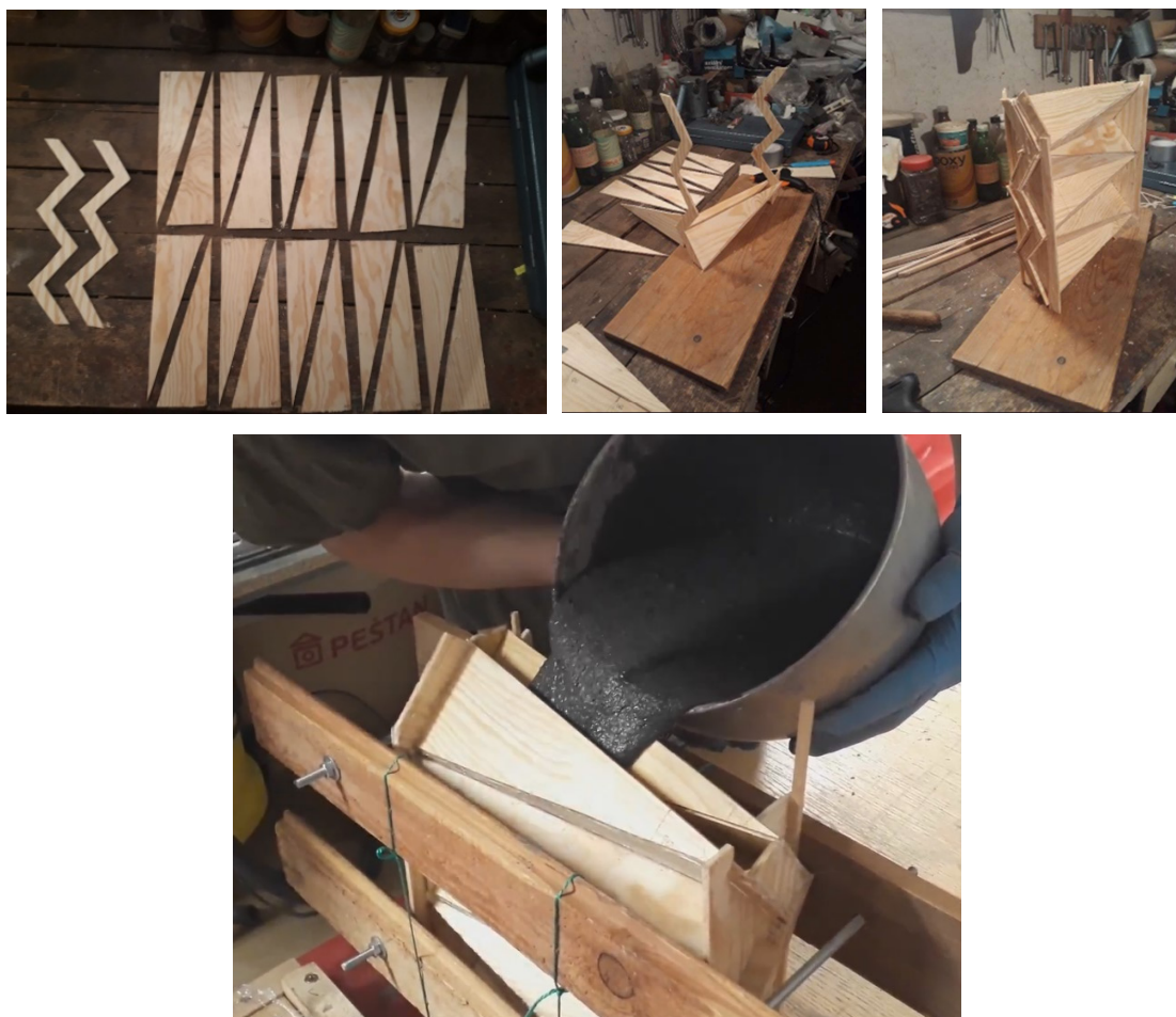
Obrázek 31: Skládání bednění a betonáž
