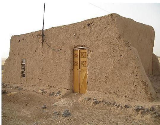
Obrázek 13: Stavba z nepálených cihel
