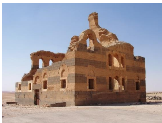
Obrázek 16: Torzo stavby ze smíšeného zdiva z pálených cihel a kamene
