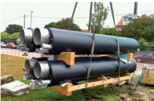
Obrázek 4 – Předizolované kanalizační potrubí s integrovaným ocelovým výměníkem tepla [5]
