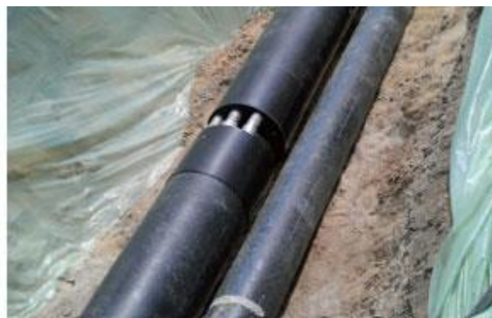
Obrázek 4 – Předizolované kanalizační potrubí s integrovaným ocelovým výměníkem tepla [5]
