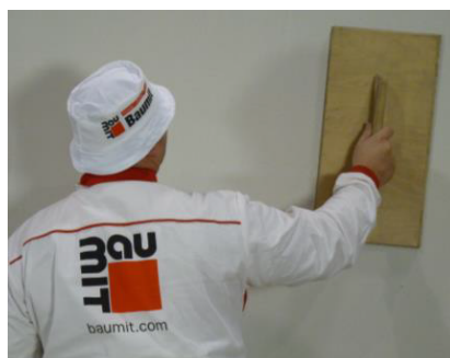
Obrázek 14 – Broušení desek tepelné izolace [28]
