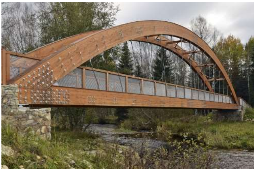
Obr. 3.15: Lávka Černý Kříž přes Studenou Vltavu [15]
