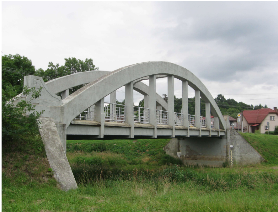
Obr. 3.11: Most v Hořepníku [9]
