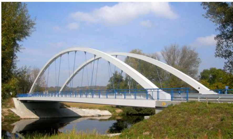
Obr. 3.16: Obloukový most přes řeku Jizeru [16]
