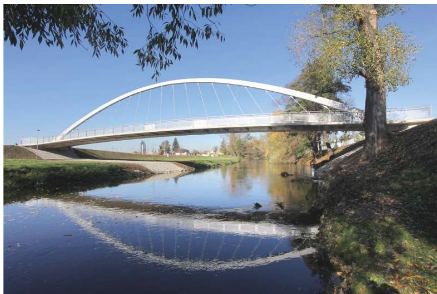
Obr. 3.14: Lávka přes řeku Svratku v Brně-Komárově [14]
