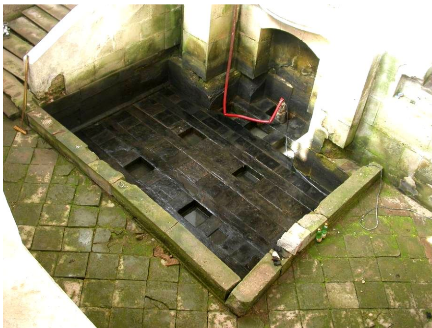
Obr. 14: Odhalený dubový rošt základové konstrukce po vyčerpání vody ze severního zrcadla (Foto: archiv SPELEO-Rehák)
