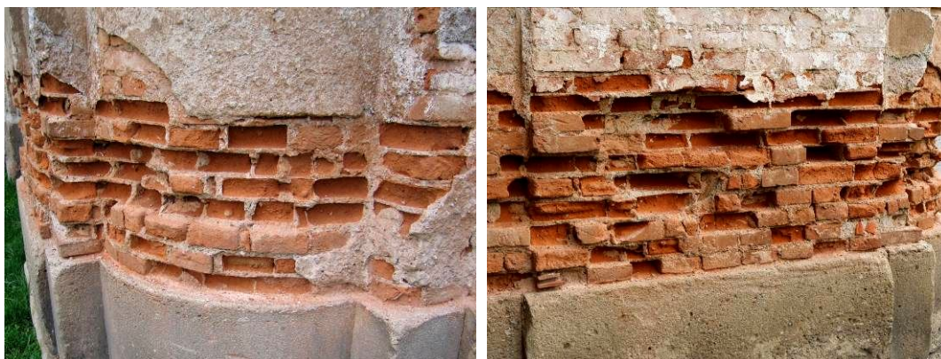
Obr. 20: Posupující degradace zdiva vlivem působení solí z přilehlé komunikace, stav zdiva a) v letech 2005, b) 2019 (Foto: J. Řehák)
