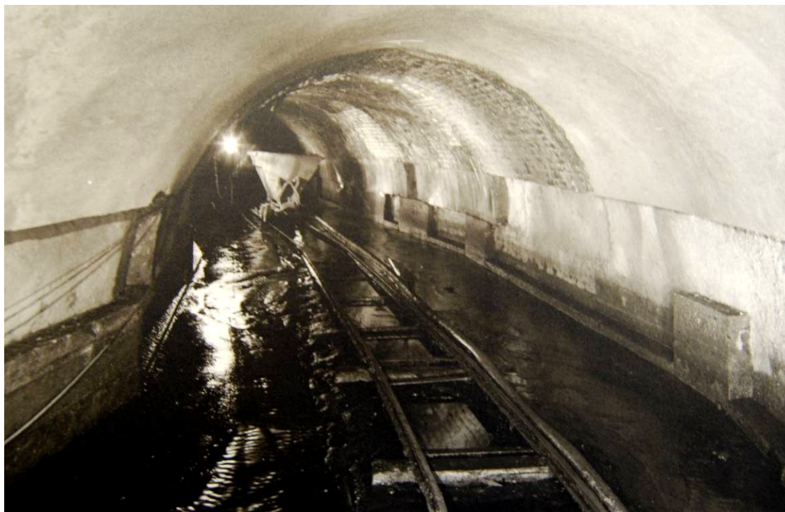
Obr. 13: Oprava Královské štoly torkrétováním z roku 1972 (Foto: archiv kláštera Plasy)
