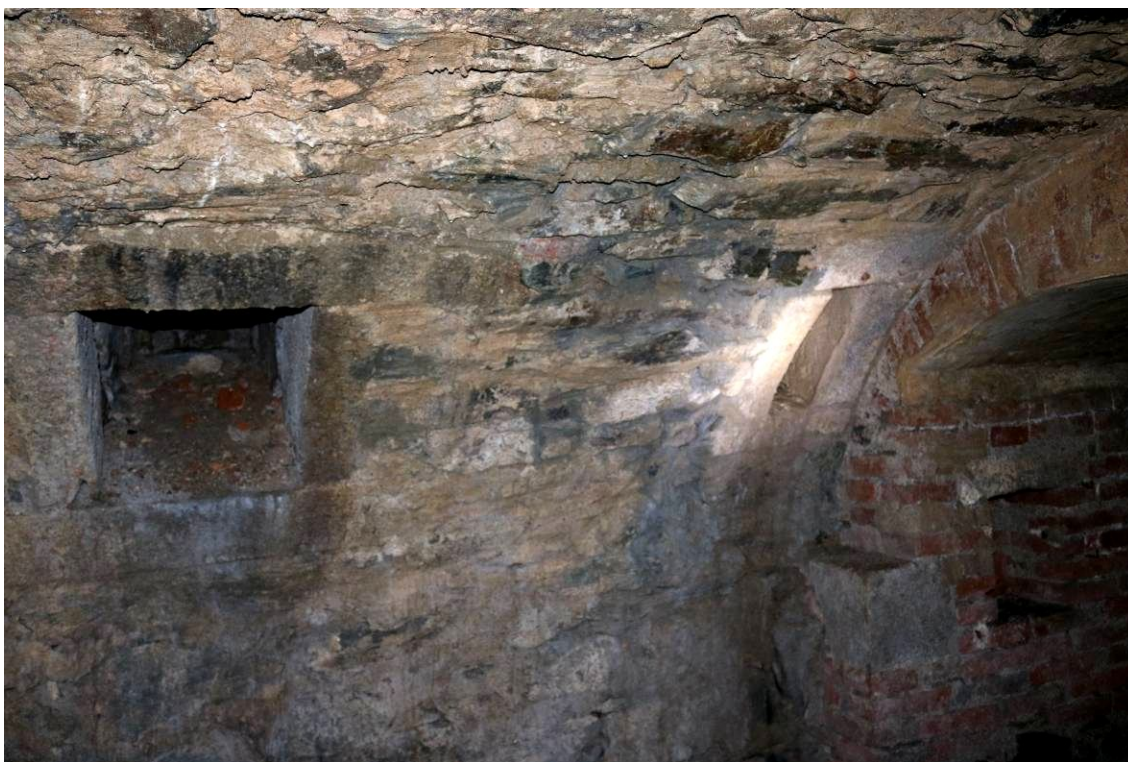
Obr. 24: Otvory v místnosti "srdce větracího systému" (Foto: J. Řehák)
