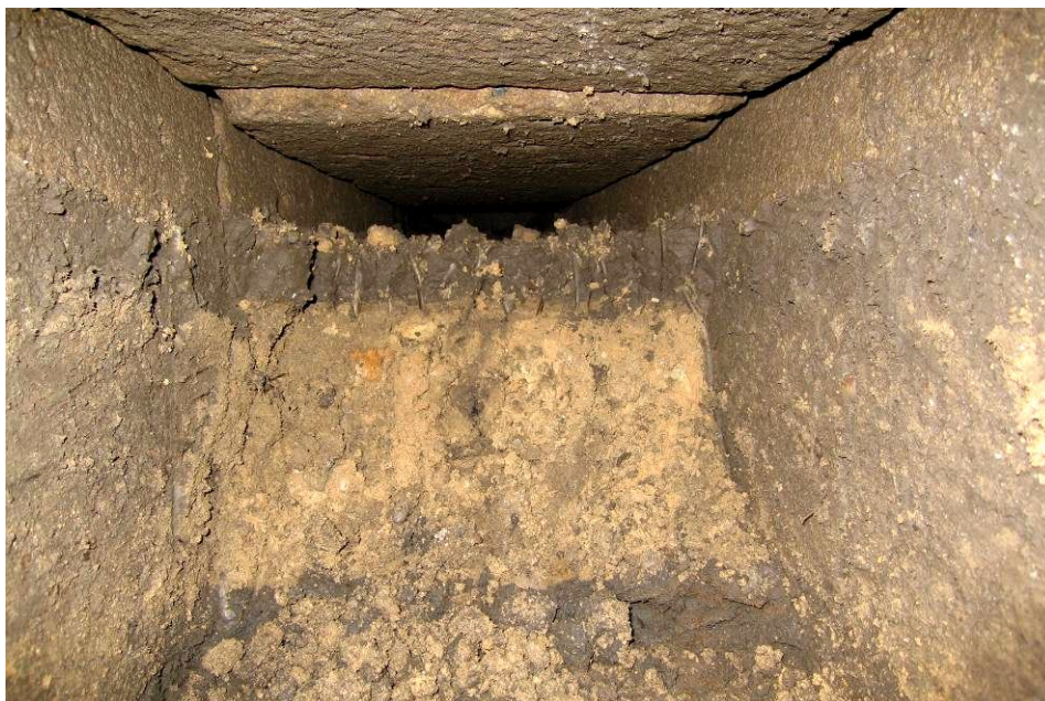
Obr. 23: Naplavený sediment v kanálku B (Foto: archiv SPELEO-Řehák)
