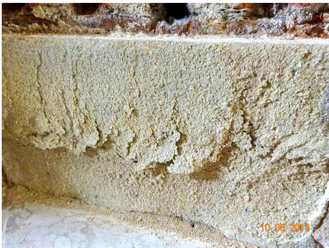
Obr. 34: Zdegradovaný pískovcový sokl v nemocničním křídle kláštera (Foto: E. Burgetová)
