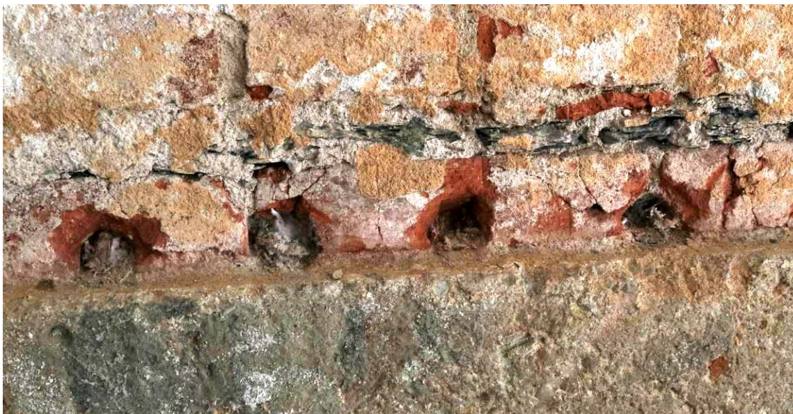
Obr. 37: Injektážní vrty pod historickou hydroizolací z břidlice (Foto: J. Řehák)
