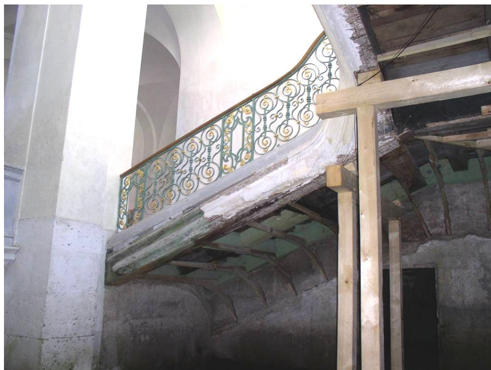
Obr. 39: Nástupní rameno dřevěného samonosného schodiště s odstraněným podhledem (Foto: J. Řehák)
