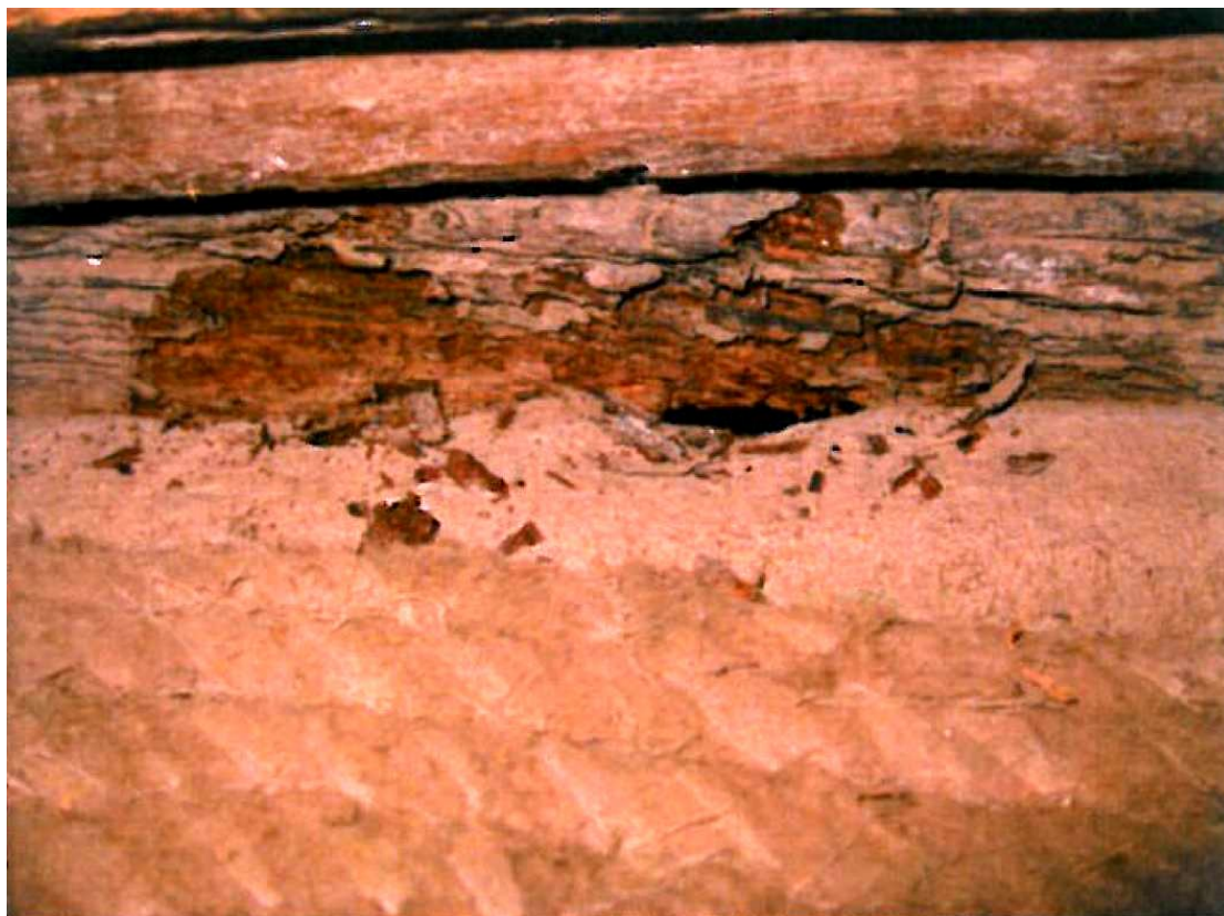
Obr. 42: Sonda 1 - odlamující se dřevní hmota (Foto: J. Řehák)
