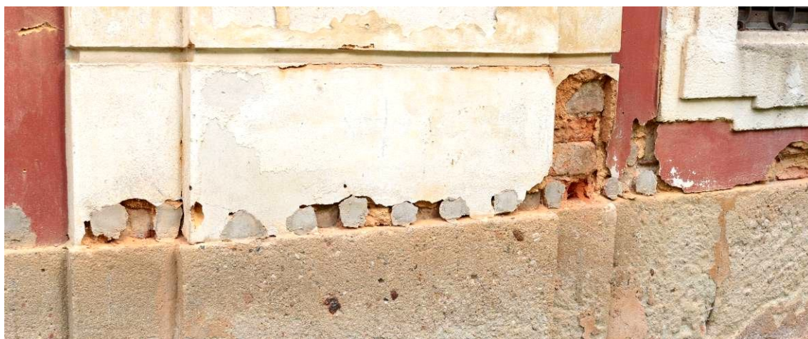
Obr. 33: Vyplněné otvory vnějších injektážních vrtů nemocničního křídla (Foto: J. Řehák)
