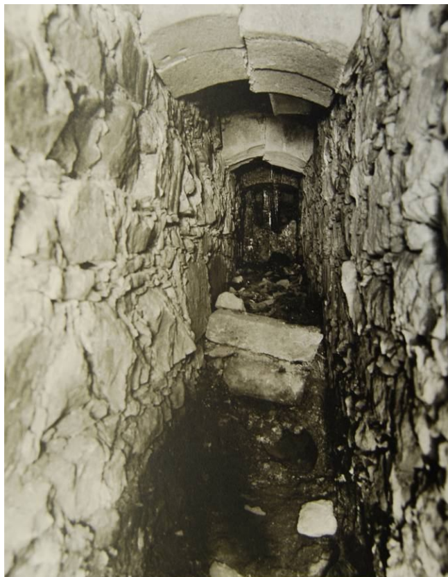
Obr. 25: Zborcené prampouchy ve vzdušníku (1972), (Foto: archiv kláštera Plasy)
