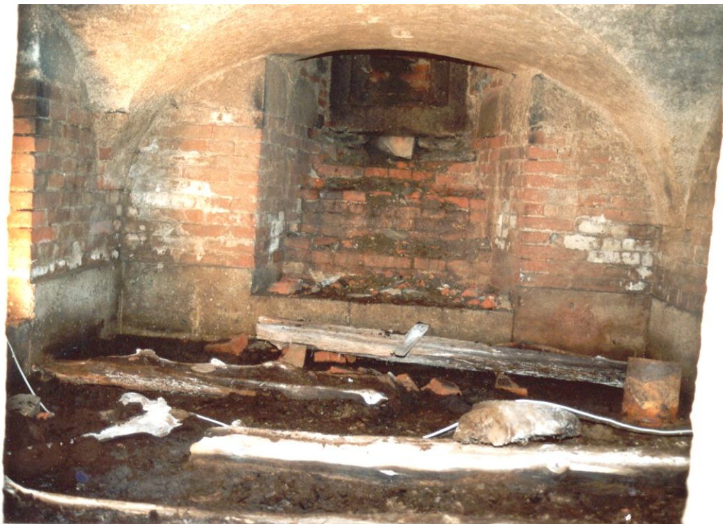
Obr. 21: Filtrační místnost se zbytky dřevěné podlahy (Foto: archiv SPELEO-ŘEHÁK)
