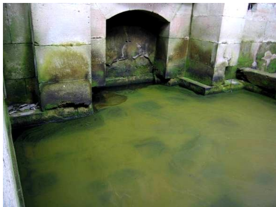
Obr. 15: Základové bazény – a) nažloutlý sediment s výskytem řas v severním zrcadle, b) skvrny v jižním zrcadle (Foto: archiv SPELEO-Řehák)
