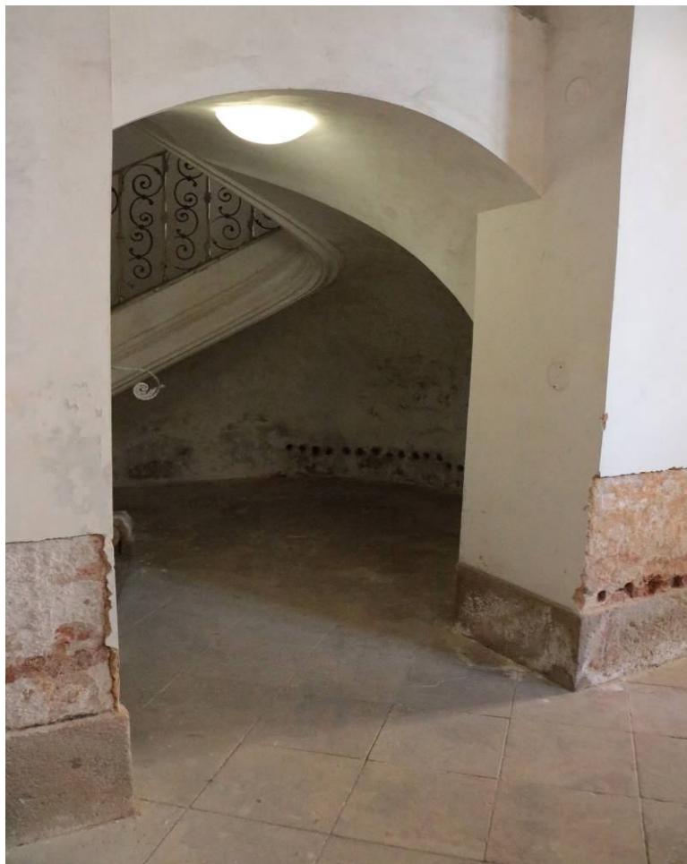
Obr. 35: Injektážní otvory v prostoru Santiniho oválného schodiště (Foto: J. Řehák)
