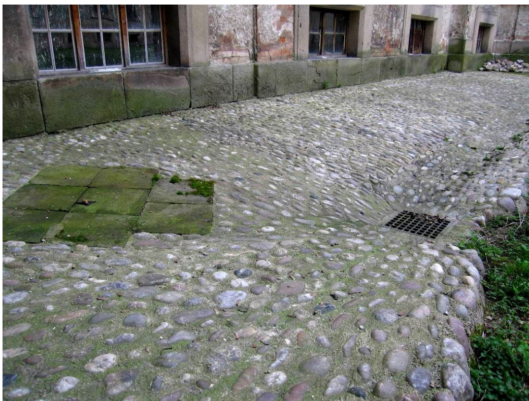
Obr. 26: Opravený okapový chodník se vpustí (Foto: archiv SPELEO-Řehák)
