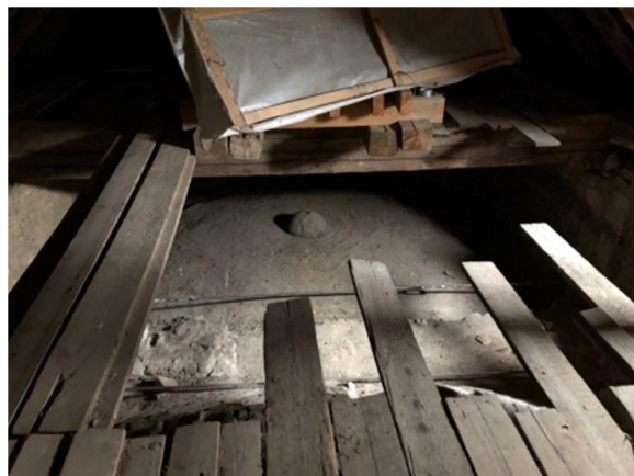
obr. 17 Klenba nad presbytářem pohled ze shora
