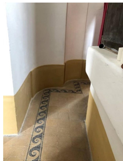
obr.23 Povrchová úprava podlahy kostela
