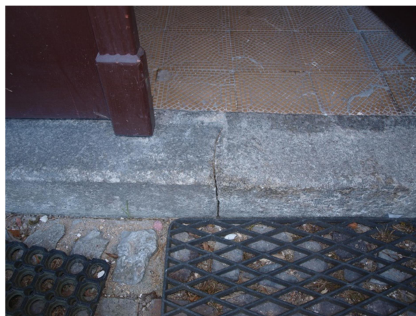
obr. 78 Svislá trhlina v tympanonu [8]
