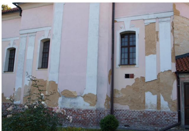
obr. 51 a 52 Důsledek působení škodlivých solí společně s vlhkostí ve zdivu kostela – exteriér a interiér
