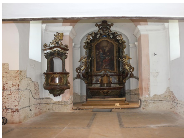
obr. 81 Odstranění omítek interiéru- východní část [8]
