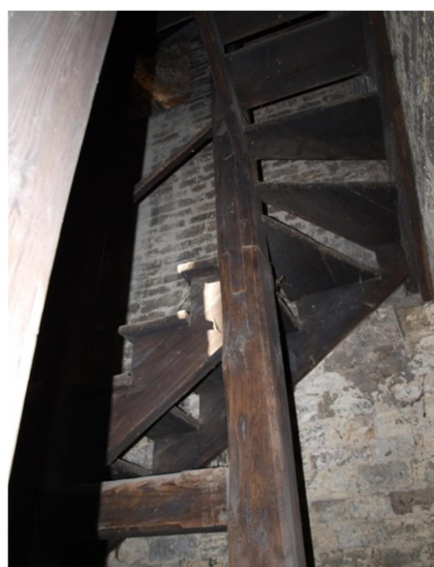
obr. 22 Dřevěné schodiště ve věži kostela
