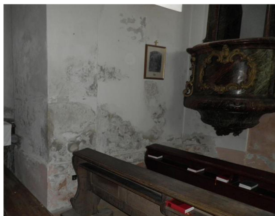
obr. 51 a 52 Důsledek působení škodlivých solí společně s vlhkostí ve zdivu kostela – exteriér a interiér
