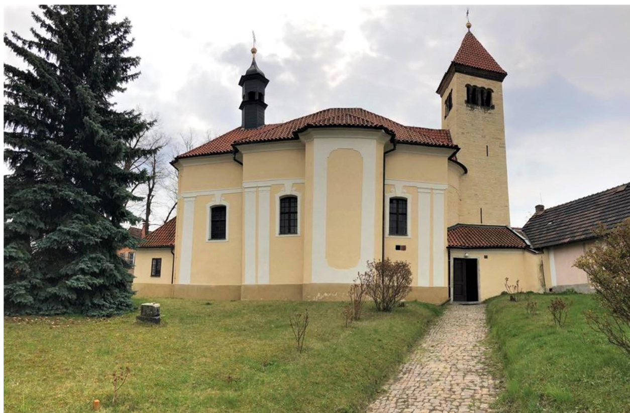
obr. 83 Stávající stav objektu – severní pohled
