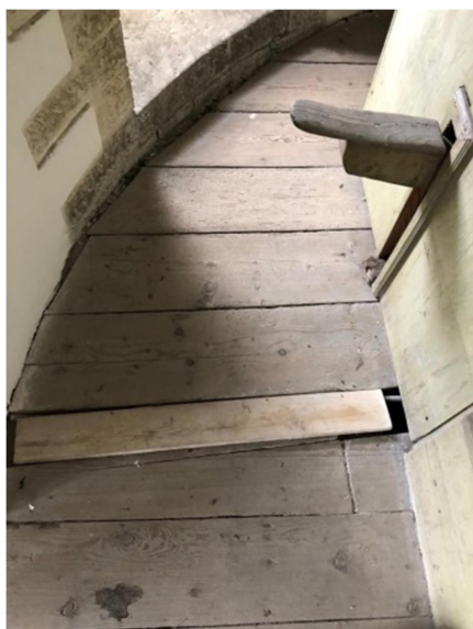
obr.14 Uvolněné prkno - podlaha krucht
