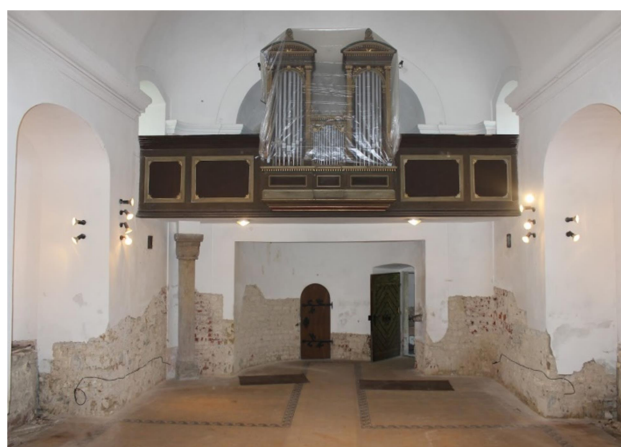
obr. 82 Odstranění omítek interiéru – západní část [8]
