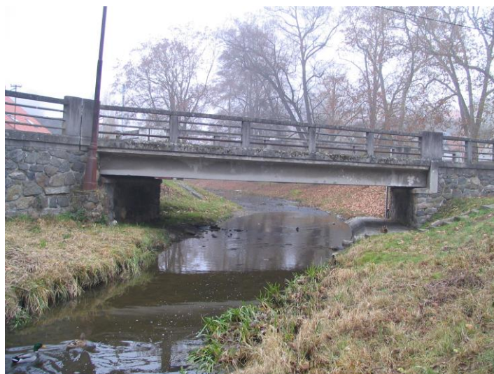
Obrázek 12 – Silniční most ř.km 26,247
