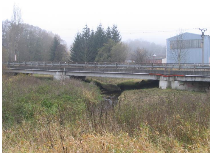
Obrázek 13 – Silniční most ř.km 24,990
