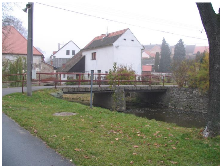
Obrázek 11 – Most místní komunikace ř. km 26,447
