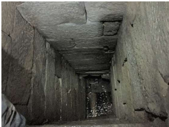
Obr. 5.25: klášter Chotěšov, pohled do žulové šachty
