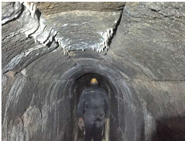
Obr. 5.22: klášter Chotěšov, štol vyzděná ze žuly, ve vrcholu klenby jsou partné průsaky vody tvořící krápníky
