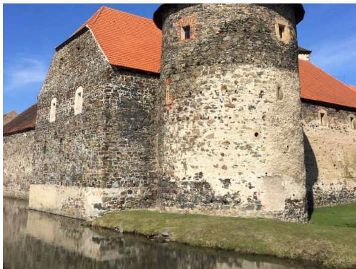
Obr. 5.9: hrad Švihov, vodní příkop izolovaný vrstvou jílu
