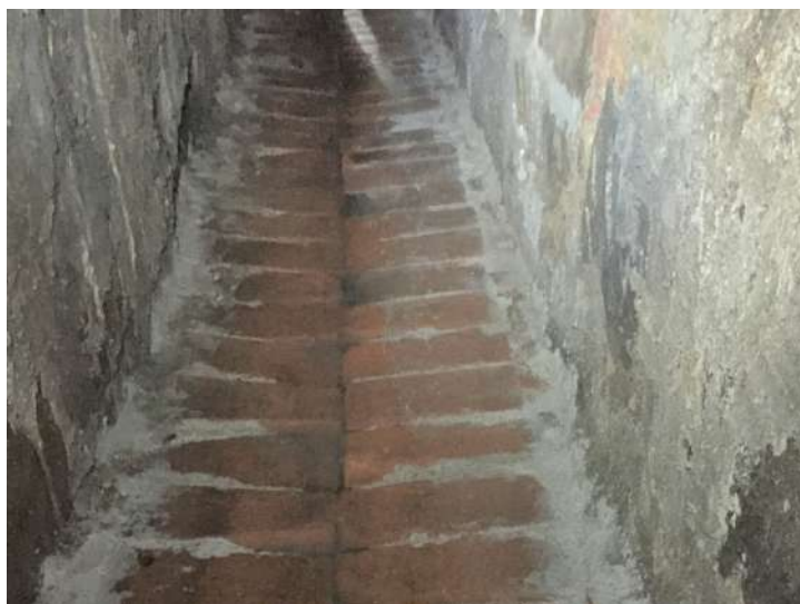
Obr. 5.24: klášter Chotěšov, vyspádané dno štoly
