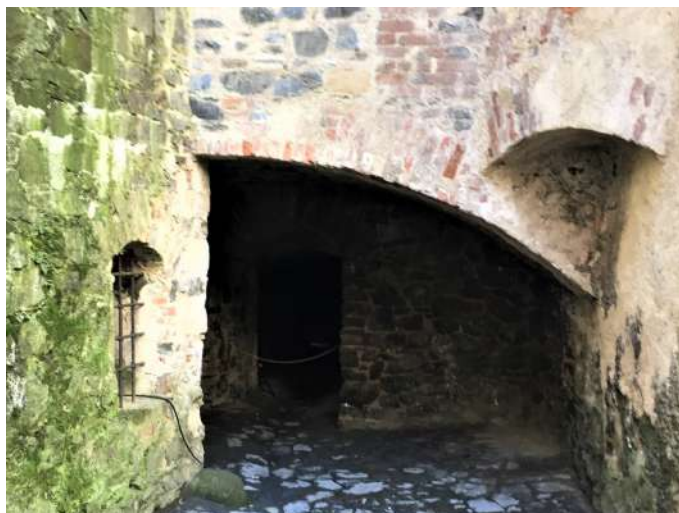
Obr. 5.6: hrad Švihov, pohled na vstup do sklepa pod spojovacím křídlem, patrný odvod vody z vnitřního nádvoří
