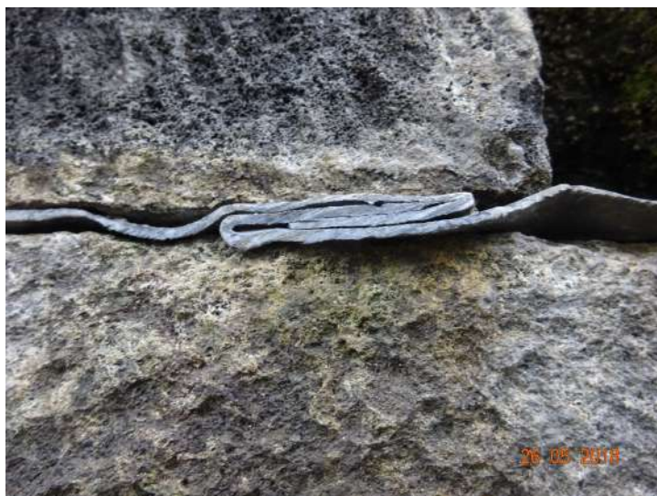
Obr. 2.8: Borobudur, detail napojení hydroizolace, převzato z [14]
