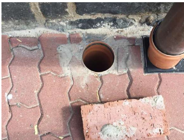
Obr. 3.7: připravený otvor pro napojení odtahového kanálu
