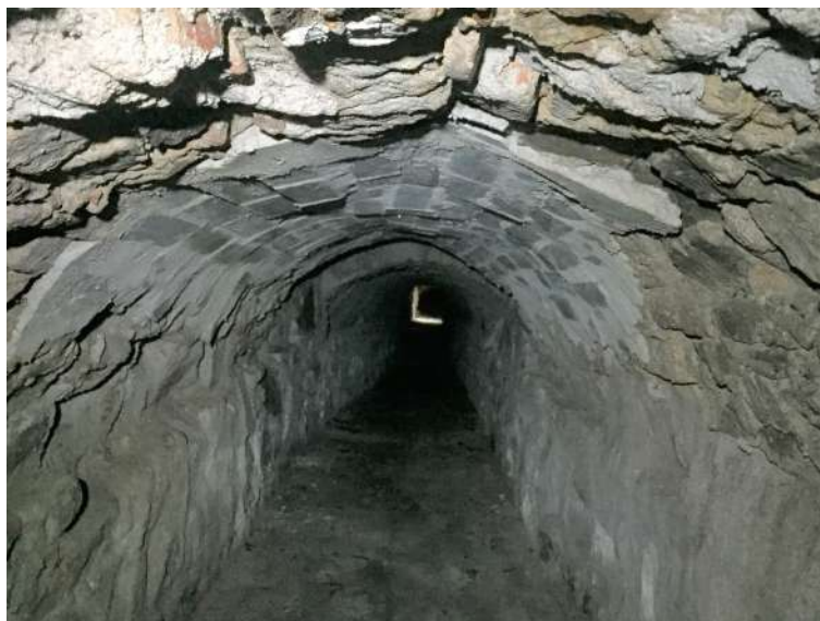
Obr. 5.22: klášter Chotěšov, štol vyzděná ze žuly, ve vrcholu klenby jsou partné průsaky vody tvořící krápníky
