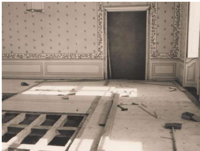
Obr. 5.19: zámek Kozel — rehabilitace odvětrávacího systému, pokládka nové podlahy, převzato z [34]
