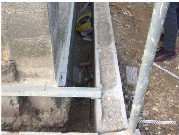
Obr. 3.6: Vzdušník, realizace pomocí tvarovek ztraceného bednění
