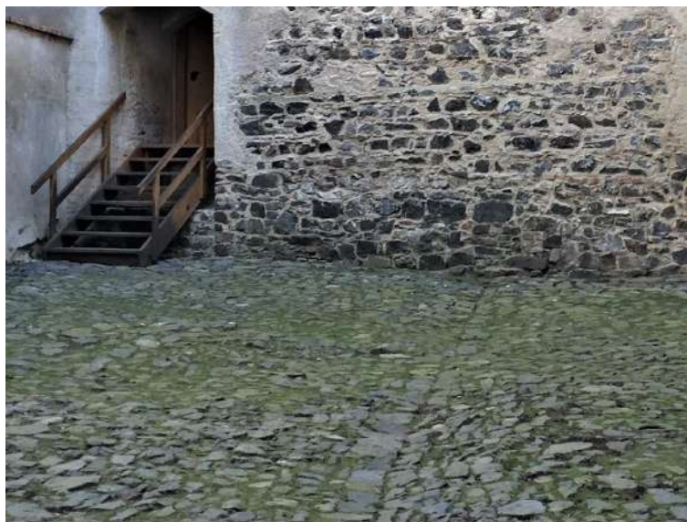
Obr. 5.4: hrad Švihov, odvodňovací žlab v podlaze vnitřního nádvoří
