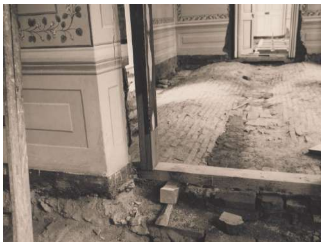
Obr. 5.16: zámek Kozel — rehabilitace odvětrávacího systému, pohled na klenbu po vytěžení škvárového zásypu, převzato z [34]
