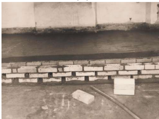
Obr. 5.16: zámek Kozel — rehabilitace odvětrávacího systému, pohled na klenbu po vytěžení škvárového zásypu, převzato z [34]
