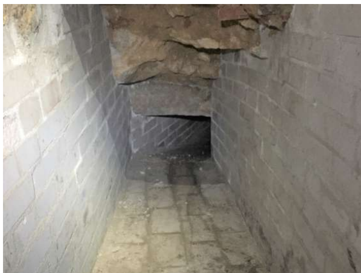
Obr. 5.26: klášter Chotěšov, opravená odvodňovací štola
