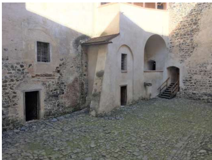
Obr. 5.5: hrad Švihov, pohled na gotickou valounovou dlažbu vnitřního nádvoří hradu
