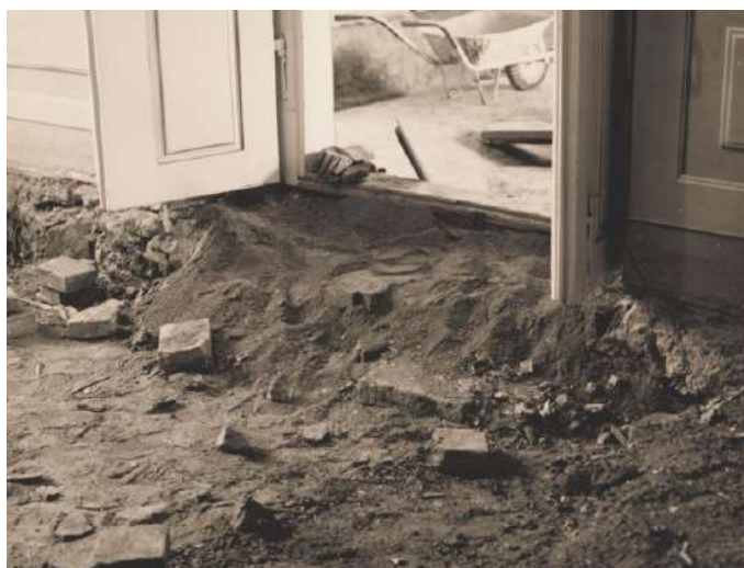
Obr. 5.15: zámek Kozel — rehabilitace odvětrávacího systému, průběh těžení škvárového záspy, převzato z [34]
