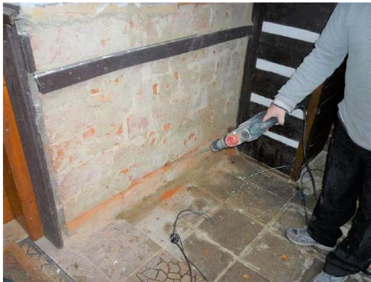
Obr. 3.13: aktivní elektroosmóza, příprava drážky pro elektrody, převzato z [23]
