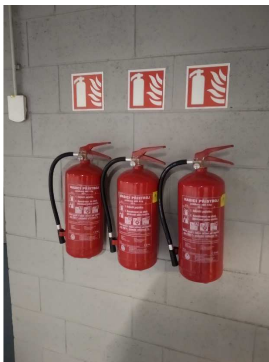
Obrázek č. 14: Umístění více PHP vedle sebe [vlastní foto]
