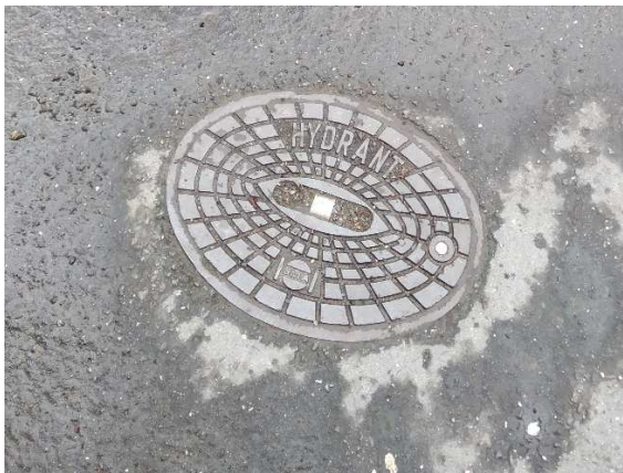
Obrázek 3: Poklop podzemního hydrantu umístěný v chodníku [Vlastní foto]
