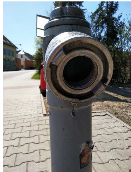
Obrázek 1 a 2: Objezdový nadzemní hydrant bez víčka [vlastní foto]
