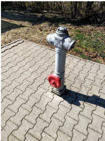
Obrázek 1 a 2: Objezdový nadzemní hydrant bez víčka [vlastní foto]
