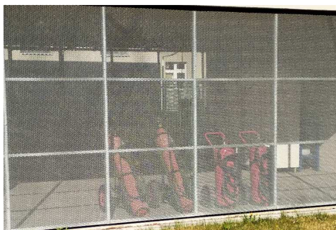
Obrázek 17: Pojízdné hasicí přístroje u skladu chemikálií ÚOCHB [vlastní foto]
