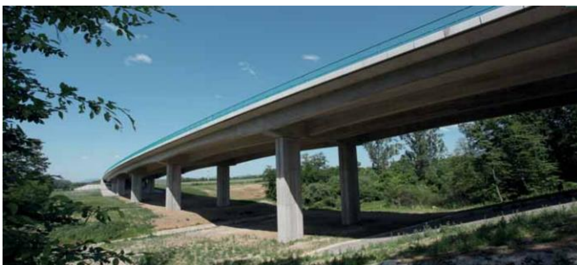
Obrázek 33 Viadukt BT 214, rychlostní komunikace R1 [16]
