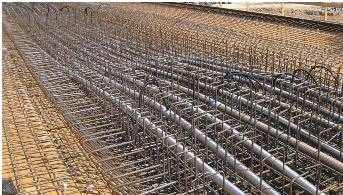
Obrázek 17 Armovací a předpínací výztuž [27]
