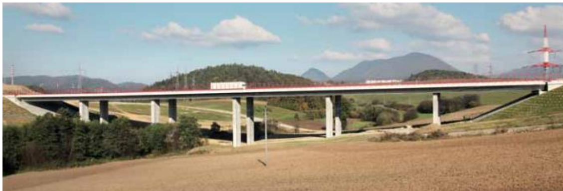
Obrázek 32 Viadukt 203, dálnice D1, stavba Sverepec-Vrtižer, Slovensko [16]
