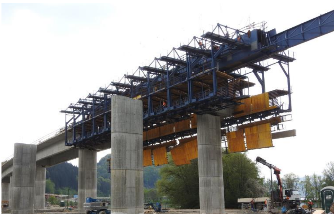
Obrázek 21 Výsuvná skruž na hlavní konstrukci [24]
