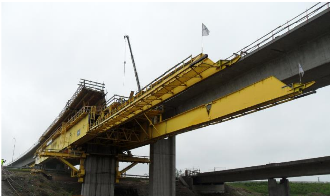
Obrázek 20 Výsuvná skruž pod hlavní konstrukcí [24]
