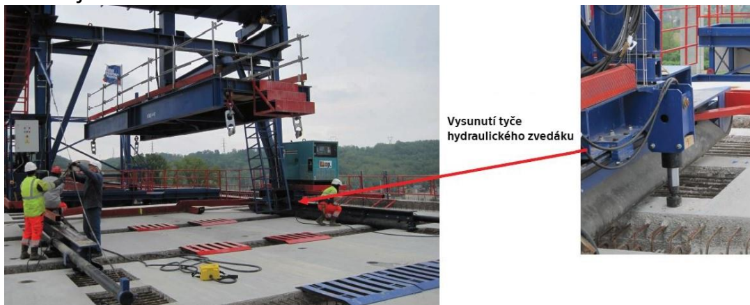
Obr. 31 Přizvednutí vozíku hydraulickými zvedáky [28]
