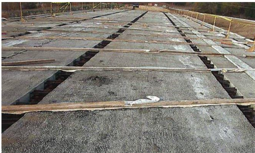
Obr. 38 Systém NU-deck použitý na Skyline Bridge, Nebraska, USA [29]
