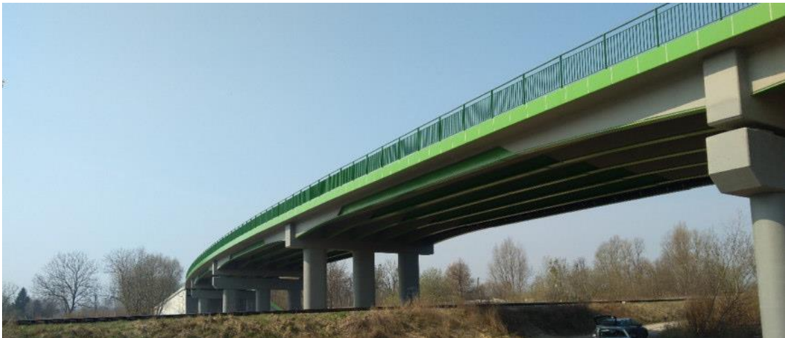
Obr. 16 Dvoustranně spřažený most Elbag, Polsko [4]
