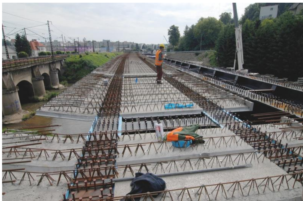
Obr. 14 Filigránové panely osazené na ocelové nosníky [14]
