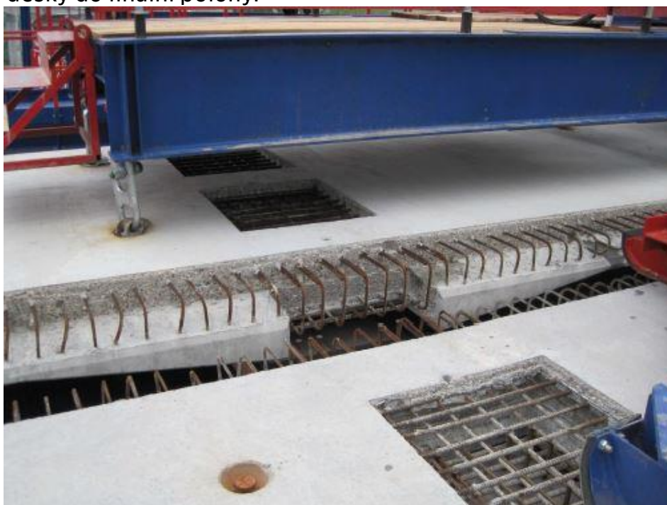
Obr. 37 Přesné osazení desky [28]
