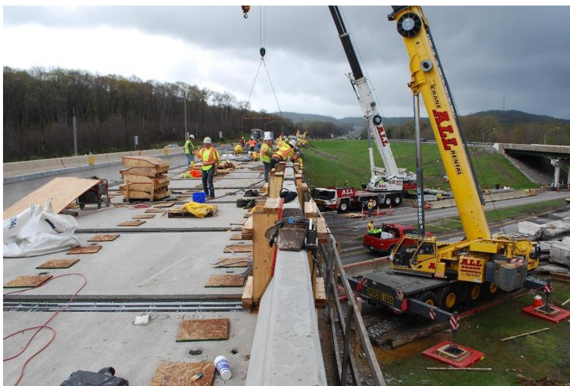
Obr. 26 Montáž dílců těžkými mobilními jeřáby [25]
