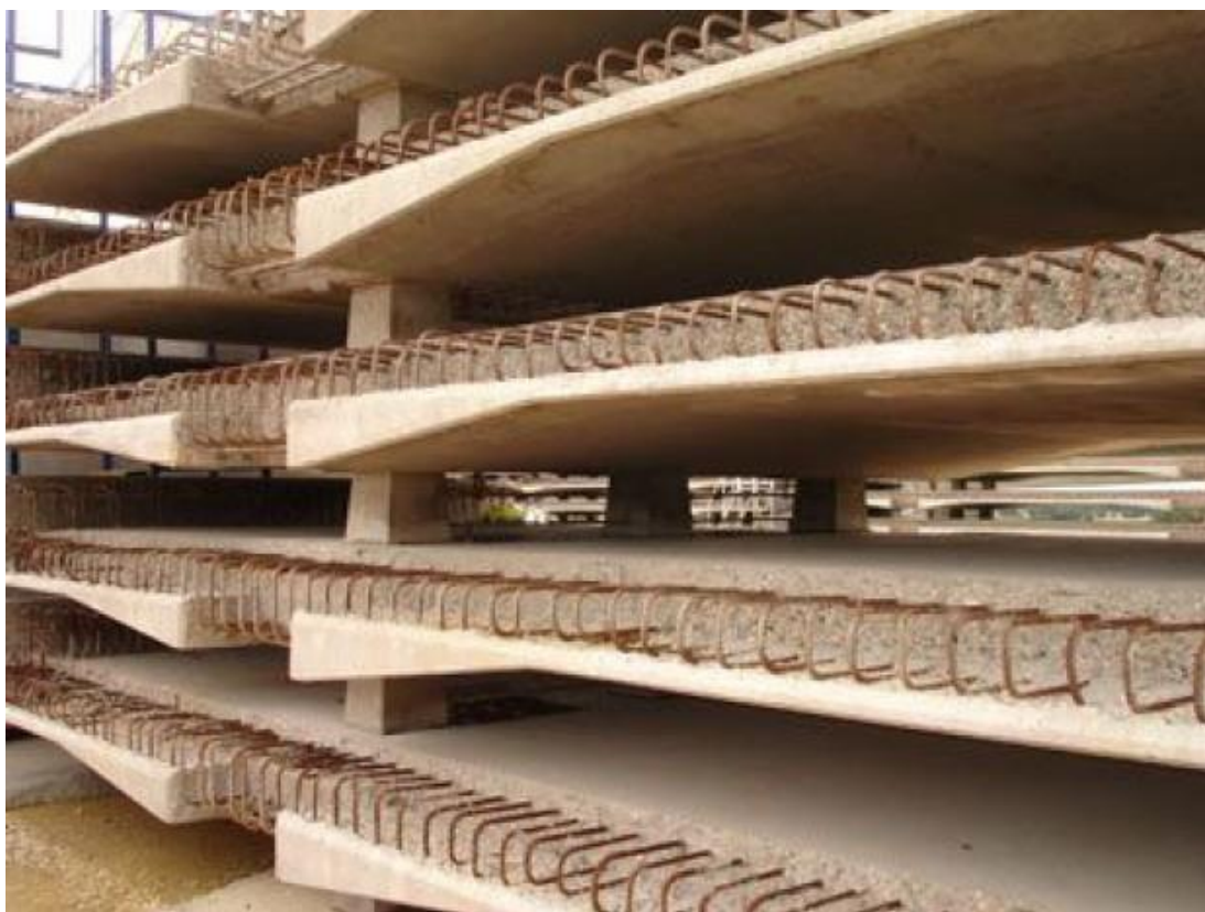
Obr. 46 Uložení prefabrikátů na skládce [37]
