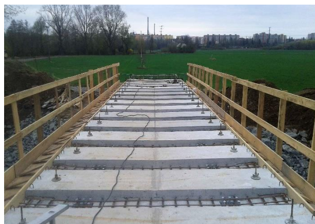
Obr. 42 Osazené prefabrikáty [32]
