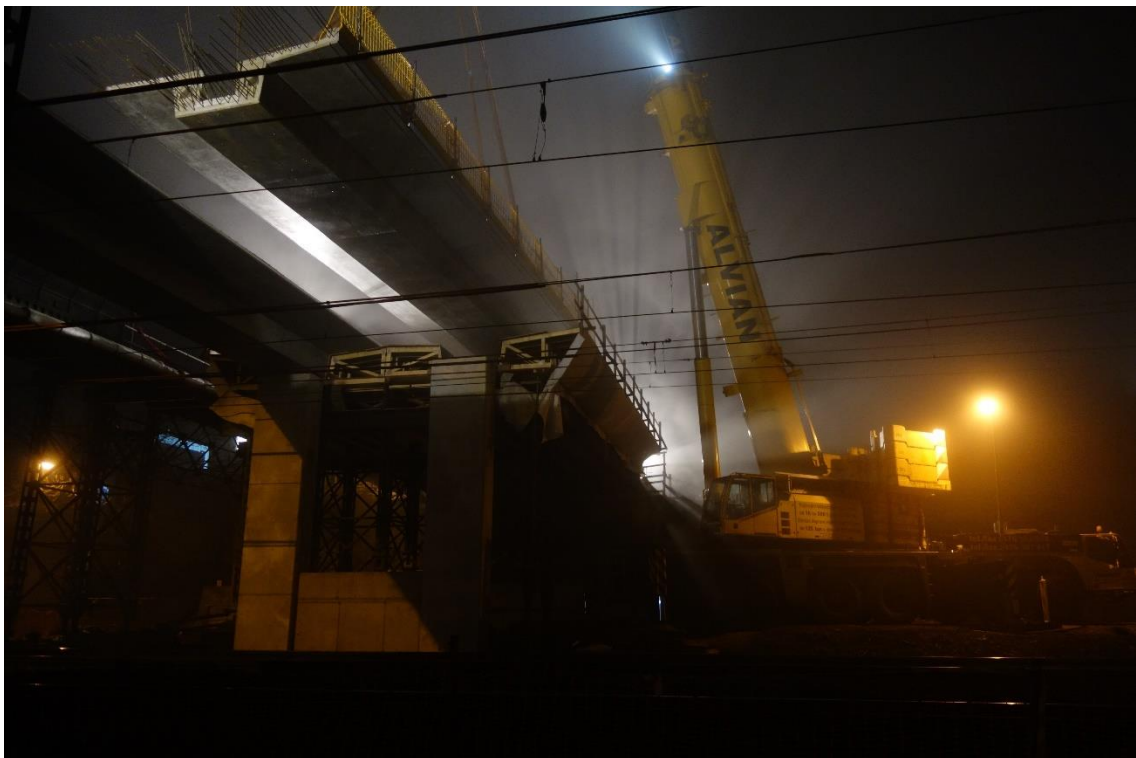
Obr. 22 Montáž staveništního prefabrikátu nosné konstrukce dvoutrámového mostu [20]
