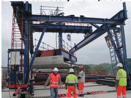
Obr. 36 Podélný transport a rotace prefabrikátu [28]
