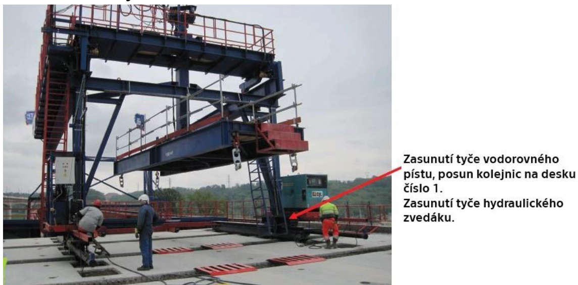
Obr. 32 Posunutí kolejnic [28]
