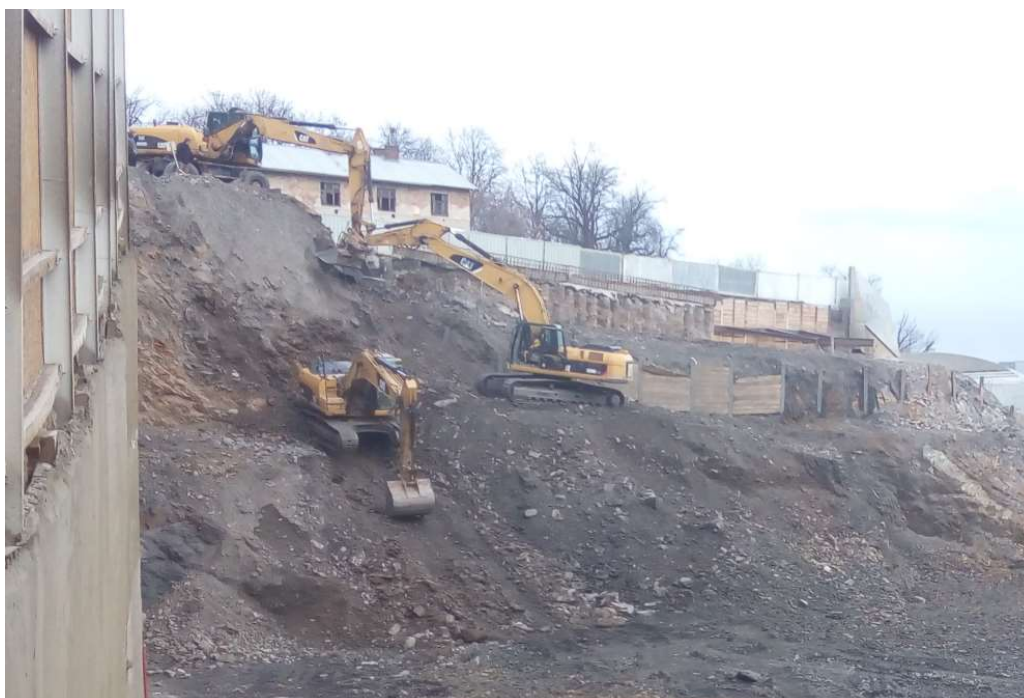
Obr. č. 7 – Kaskádovitá těžba sjezdové rampy Zdroj: Autor
