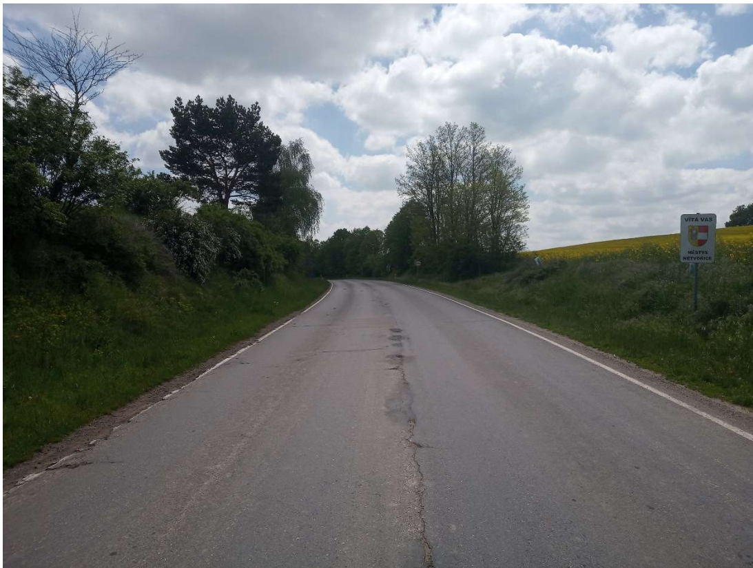
Obrázek 6: km 0,00000 – Silnice II/105, pohled z místa stávající křižovatky silnic II/105 a III/1056 směrem do Netvořic
