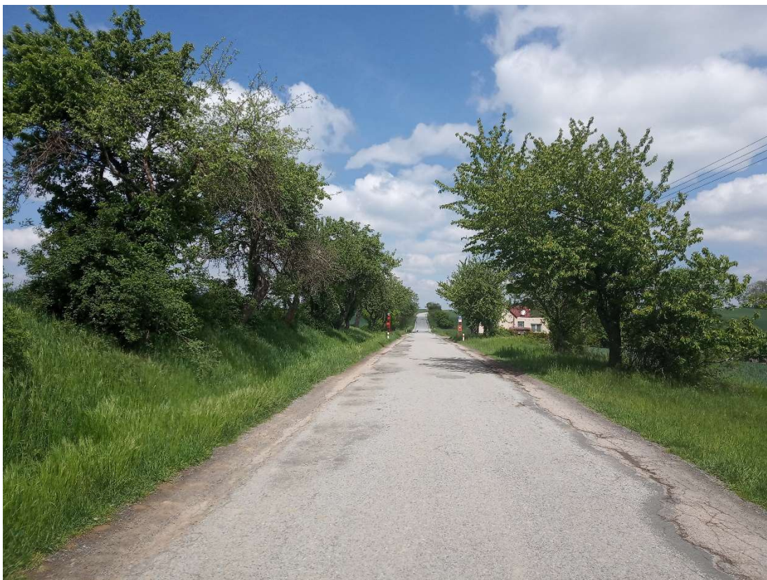
Obrázek 11: km 1,20000 – Silnice III/1065, alej, nadzemní elektrické vedení NN, autobusová zastávka, pohled směr Břežany
