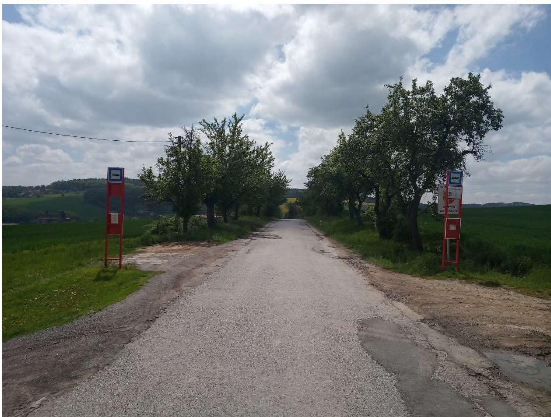
Obrázek 10: km 1,20000 – Silnice III/1065, alej, nadzemní elektrické vedení NN, autobusová zastávka, pohled směrem do Netvořic
