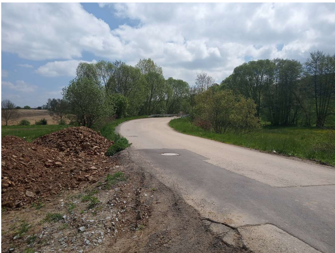
Obrázek 14: km 2,04470 – Pravotočivý směrový oblouk napojující obchvat na silnici III/1057 resp. její přeložku (SO 303 123 – přeložka silnice III/1057 23,4 – 24,0) navrženou v rámci stavby D3 0303 Hostěradice – Václavice
