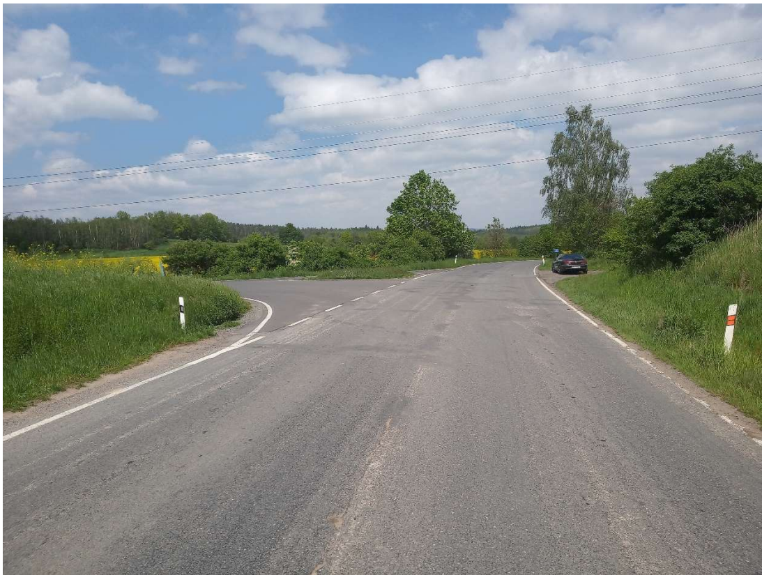
Obrázek 5: km 0,00000 – Napojení na silnici II/105 okružní křižovatkou v místě stávající křižovatky silnic II/105 a III/1056, pohled od Netvořic
