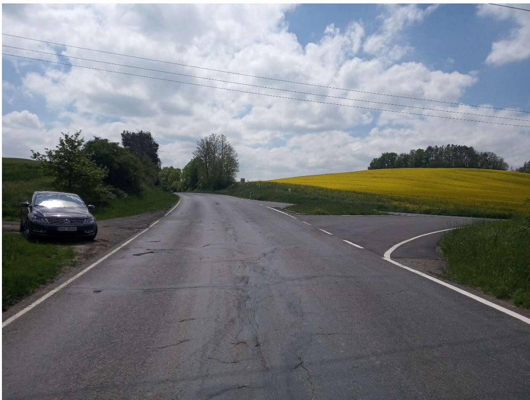
Obrázek 3: km 0,00000 – Napojení na silnici II/105 okružní křižovatkou v místě stávající křižovatky silnic II/105 a III/1056, pohled od Kamenného Přívozu
