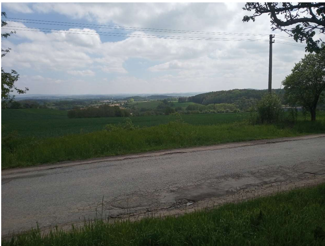
Obrázek 8: km 1,20000 – 2,04470 – Zájmové území, silnice III/1065, nadzemní elektrické vedení NN
