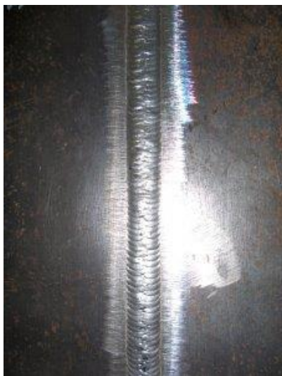
Obr. 30: Správně provedený svar [18]
