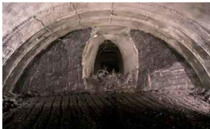
Obr. 4 Průzkumná štola v profilu třípruhového tunelu [7]
