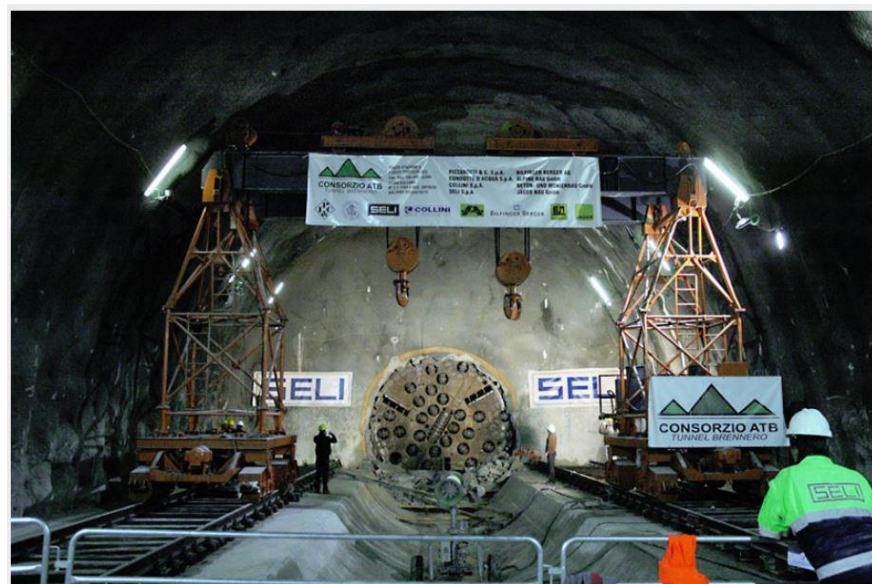
Obr. 31 Prorážka průzkumné štoly [24]
