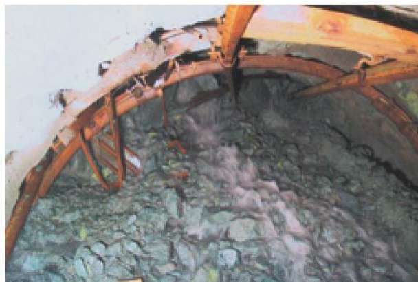
Obr. 22 Zával způsobený sufozními účinky tlakové vody v tektonické poruše ZP [14]
