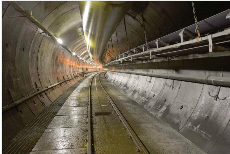
Obr. 30 Segmentové ostění průzkumné štoly Aica [23]
