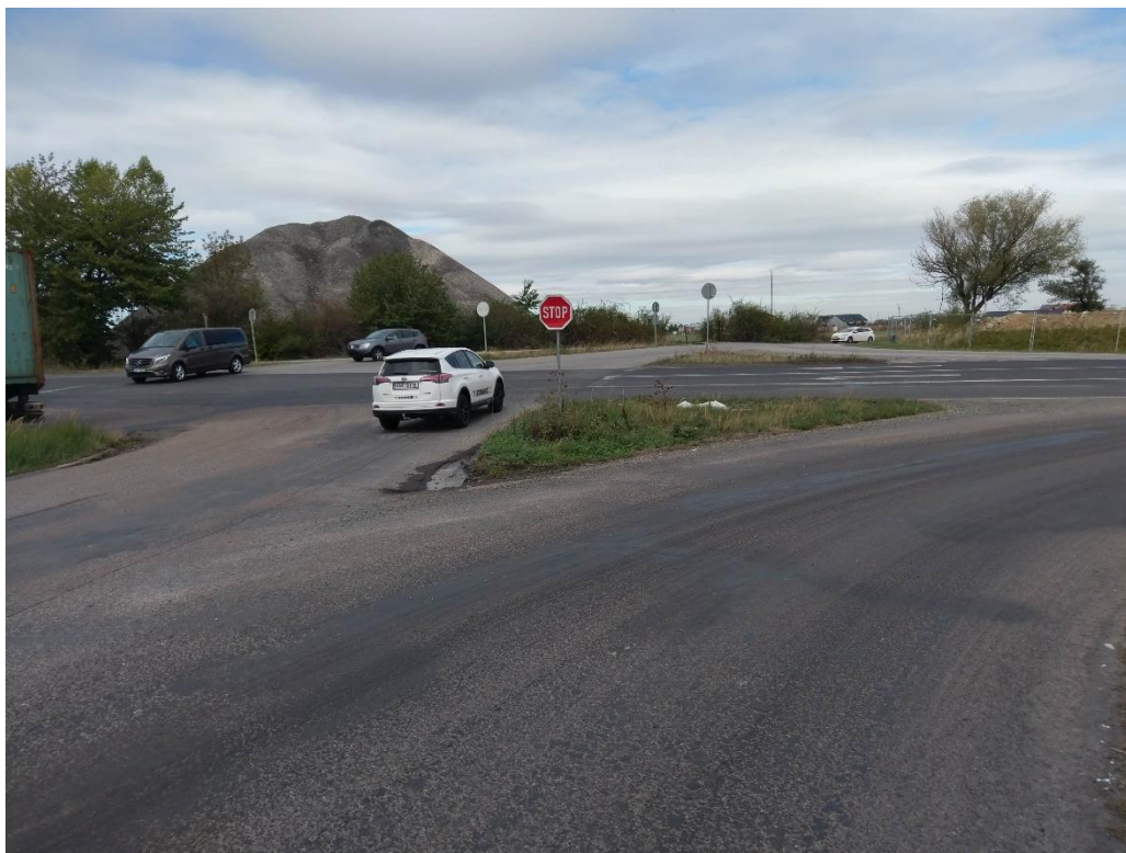
Obrázek 6 – křižovatka silnic II/101, III/00316 a III/00317, pohled na ostrůvek ze silnice K Herinku
