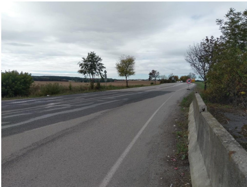
Obrázek 3 – silnice II/101, pohled z větve pro odbočení ze silnice Jesenická
