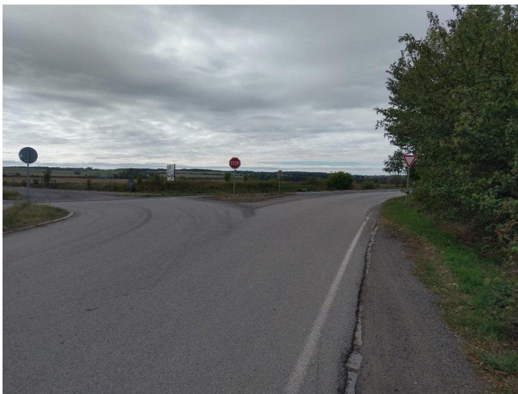
Obrázek 2 – křižovatka silnic II/101, III/00316 a III/00317, pohled na větev pro odbočení ze silnice Jesenická
