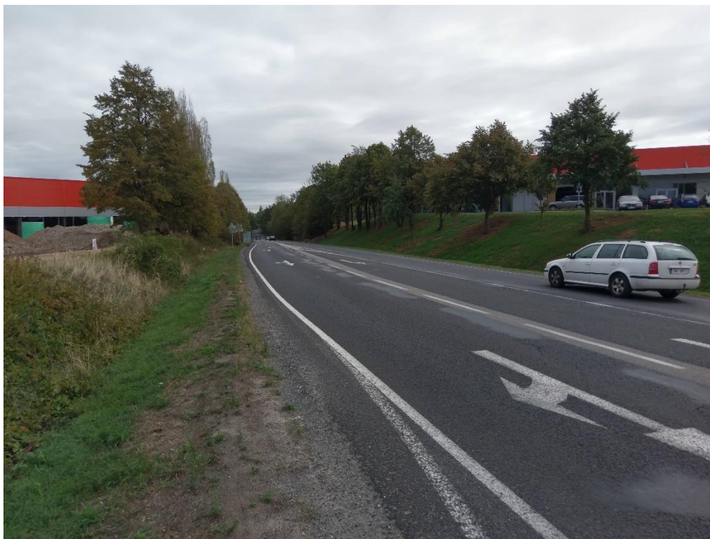
Obrázek 10 – silnice II/101, pohled z větve pro odbočení na silnici Jesenická
