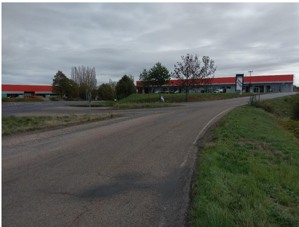
Obrázek 4 – křižovatka silnic II/101, III/00316 a III/00317, pohled na větev pro odbočení ze silnice 101 na silnici K Herinku
