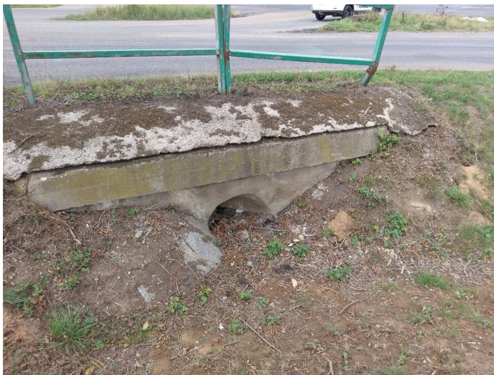
Obrázek 7 – východní pohled na propustek pod silnicí k Herinku
