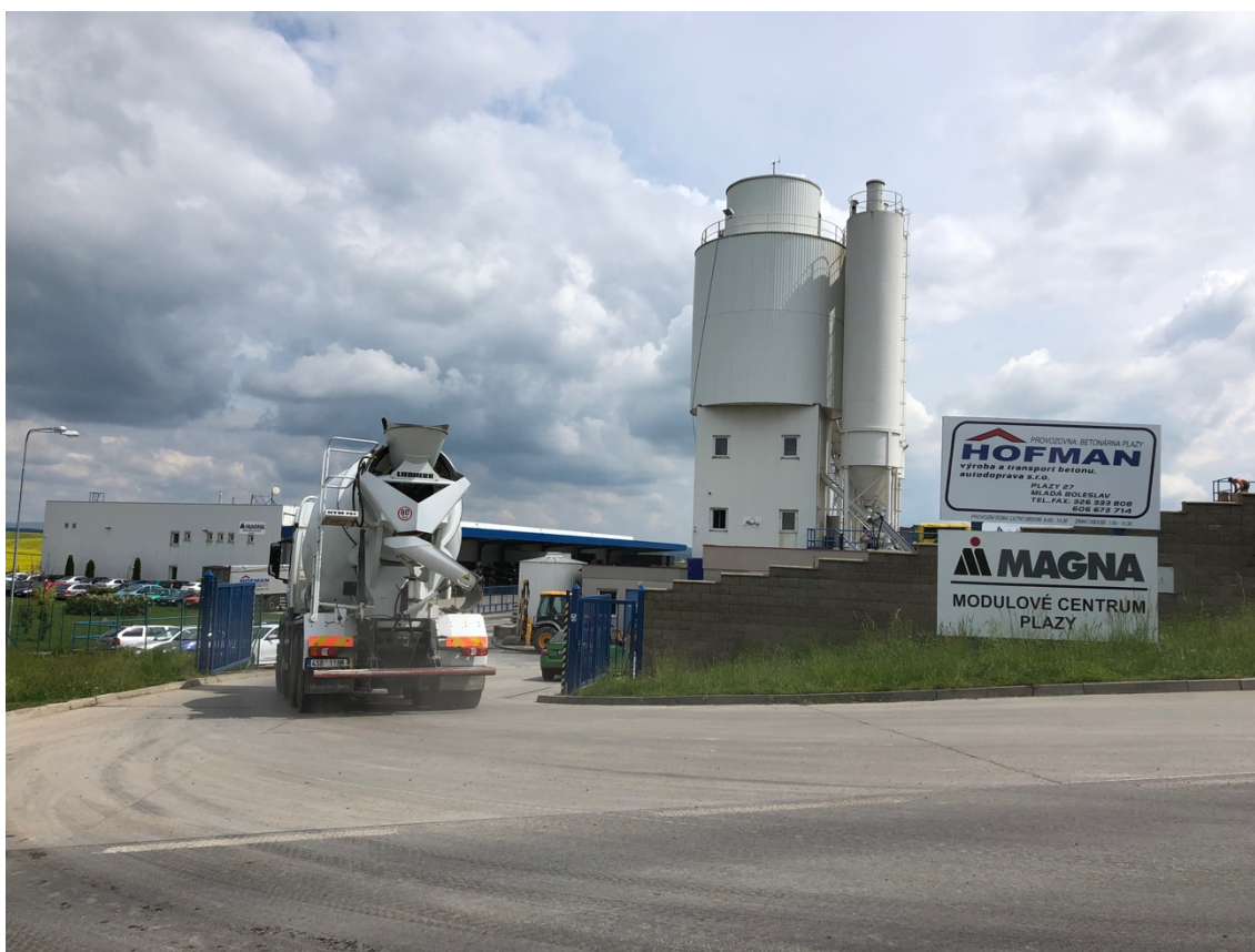
Obr. 8 – Betonárna Hofman Plazy
