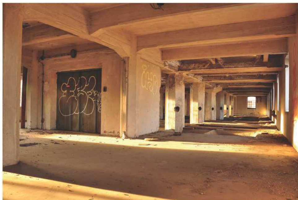
STÁVAJÍCÍ NÁKLADNÍ VÝTAH
