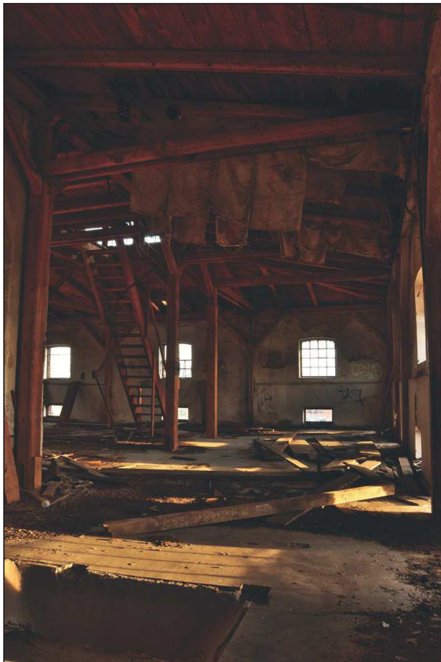
POHLED NA KONSTRUKCI KROVU
