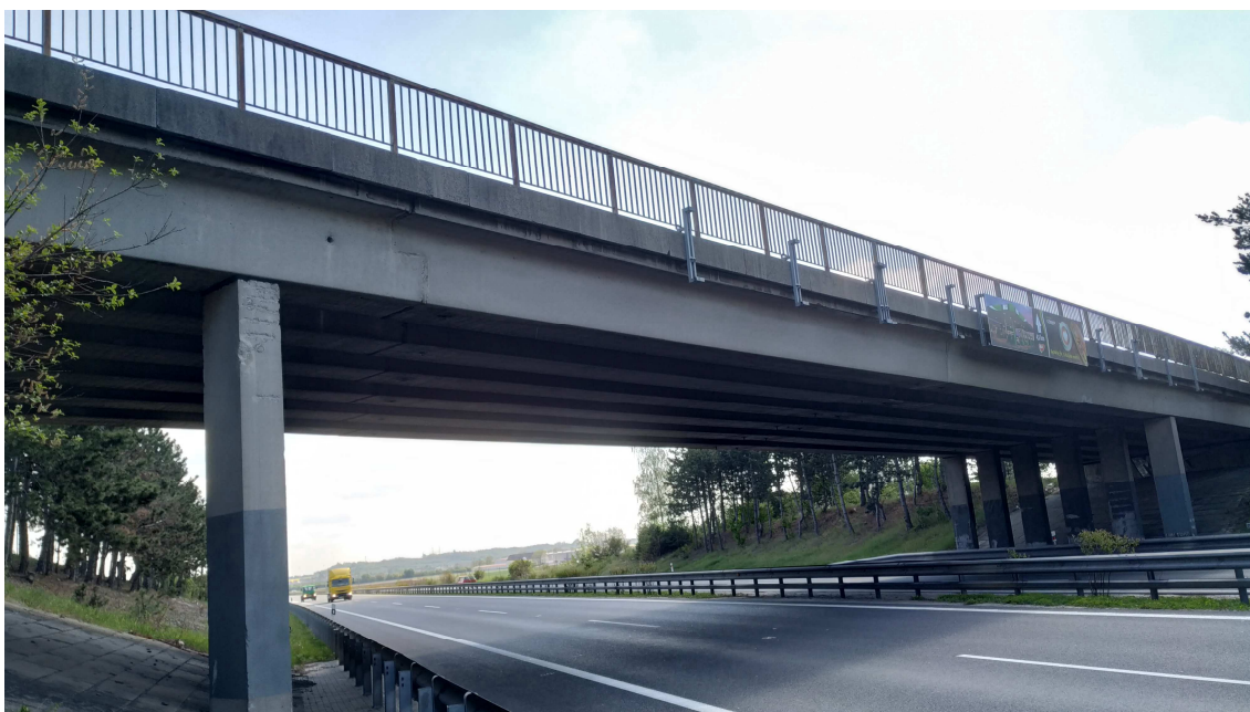
Pohled na stávající most ze západní strany
