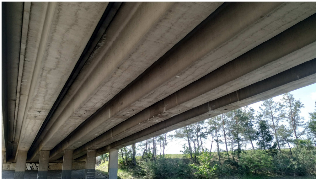
Obrázek 2 - Pohled zespoda na nosnou konstrukci
