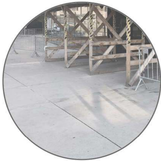
BETONOVÁ LITÁ DLAŽBA (DILATACE PO CCA 4 m)
