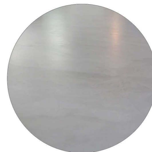
LITÁ EPOXIDOVÁ PODLAHA
