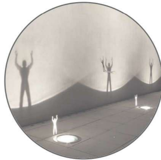
NASVÍCENÍ BUDOVY ELEKTRÁRNY V TRÁVNÍKU
