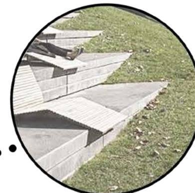
sezení zapuštěné do svahu
