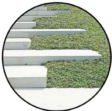
betonové schodiště zapuštěné do terénu
